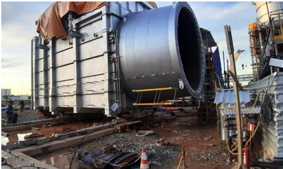
Montagem e instalação do DIVERTER DAMPER na unidade 22
