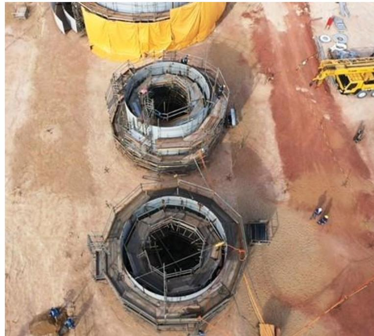
Montagem dos Tanques de Água Desmineralizada
