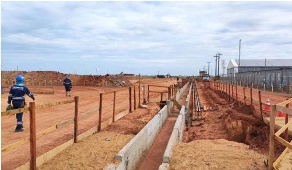
Execução da Canaleta de Drenagem Pluvial
