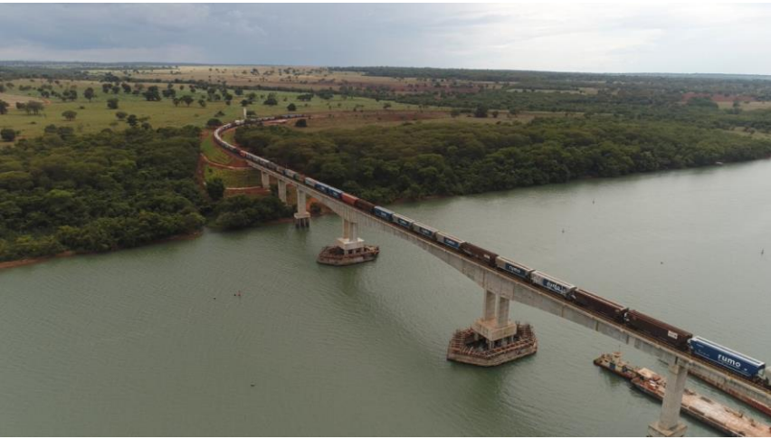
Ponte sobre o Rio Paranaíba (MG/GO)
