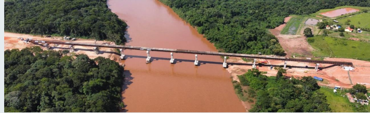
Bridge over the Rio Vermelho 35 km from Rondonópolis.
