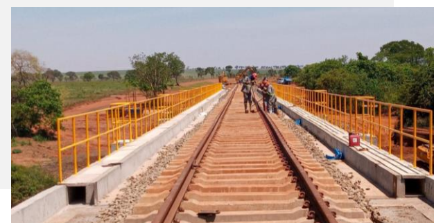
Ponte sobre o Rio Arantes (MG)
