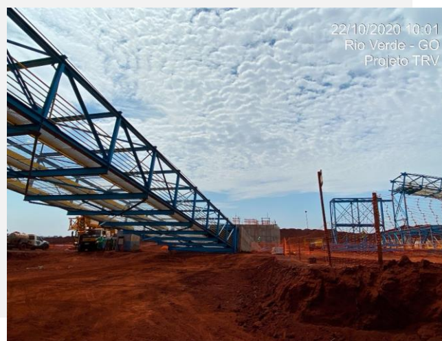
Galerias metálicas – Rio Verde (GO)
