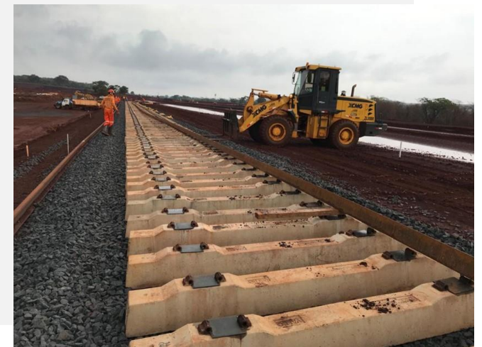
Instalação de dormentes – Rio Verde (GO)
