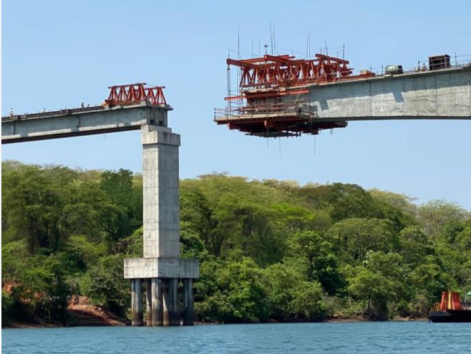
Ponte sobre o Rio Paranaíba (MG/GO)
