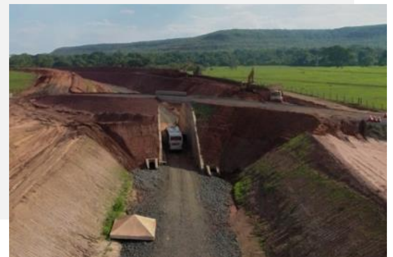
Passagem superior no trecho de Quirinópolis (GO)
