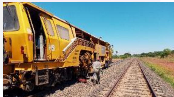
Nivelamento de via
