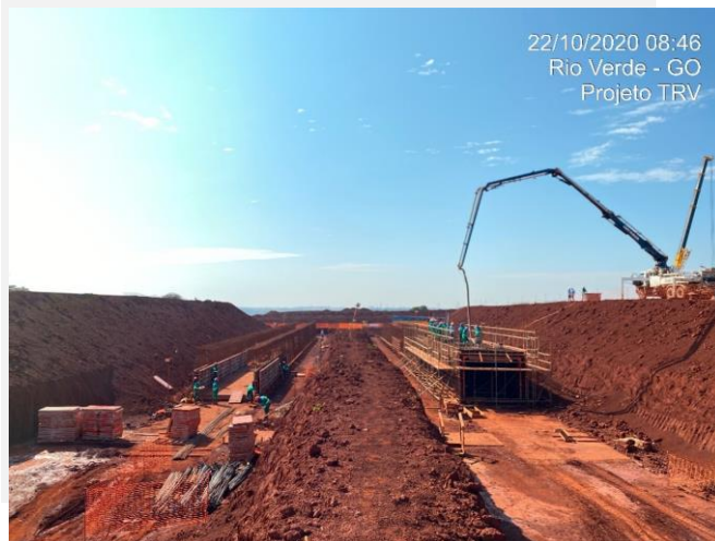
Túneis do armazém – Rio Verde (GO)
