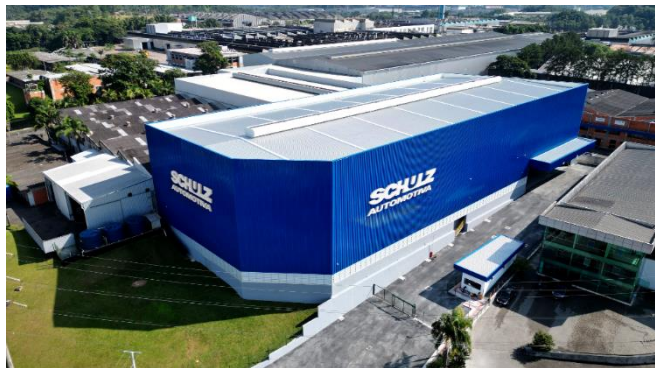
Centro de Armazenagem Vertical com 19 metros de pé direito, único no país com estas dimensões e com gerenciamento integrado a Inteligência Artificial.
