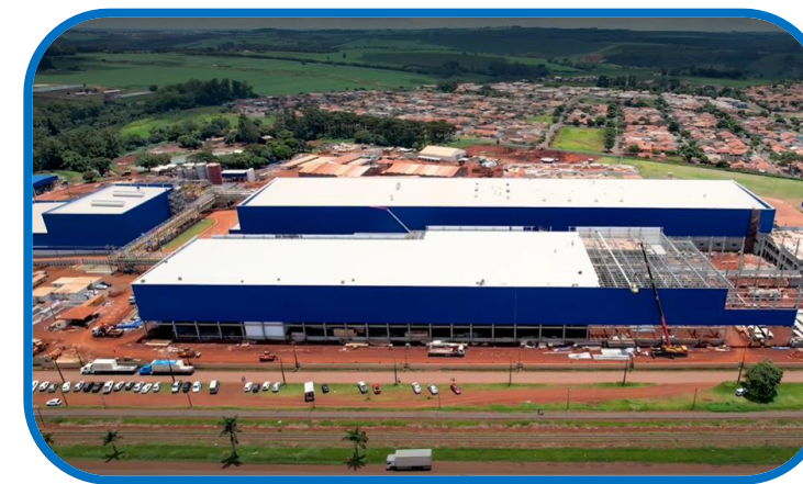
Unidade da Seara em Rolândia-PR (previsão mar/23)
