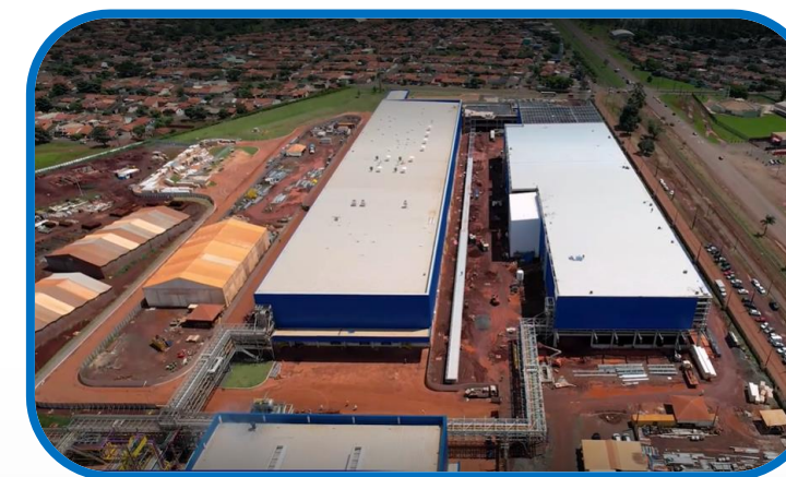
Unidade da Seara em Rolândia-PR (previsão mar/23)
