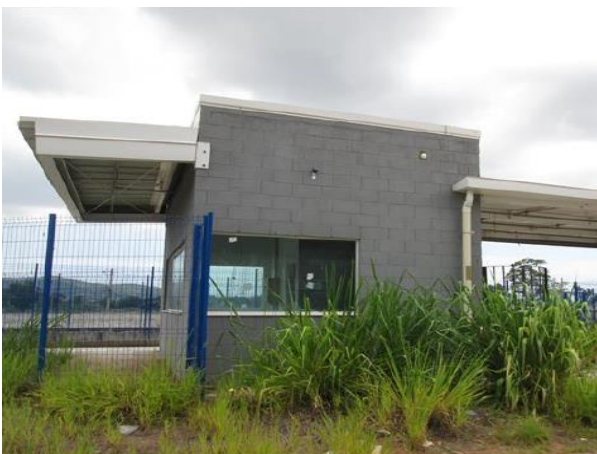
Edificação 3 – Portaria (Fachada)
