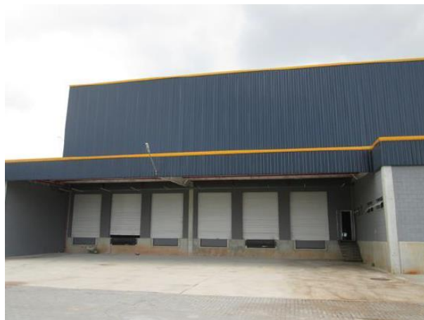
Edificação 1 – Galpão (Docas)
