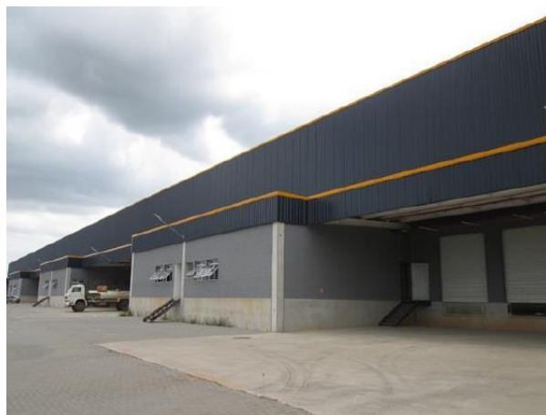
Edificação 1 – Galpão (Fachada)
