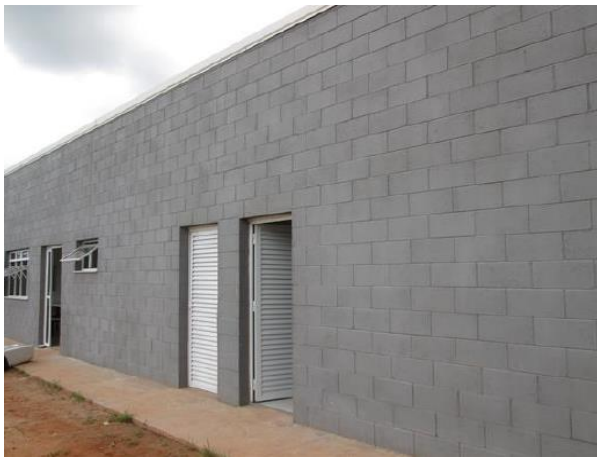
Edificação 2 – Refeitório (Fachada)
