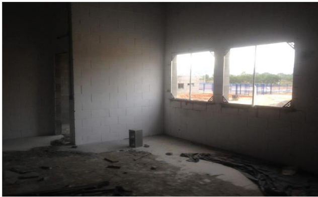
Assentamento Pingadeiras em Janelas dos Kits.
