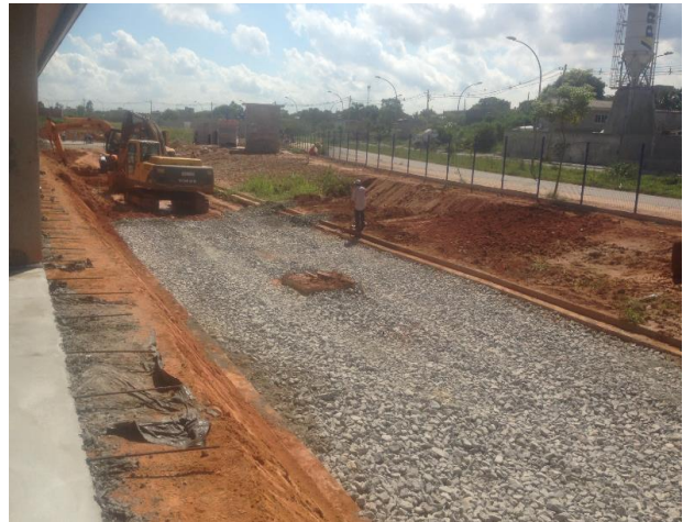
Acerto de Base e Corte de Talude em Rua Interna Paralela a Estrada dos Guaranis.
