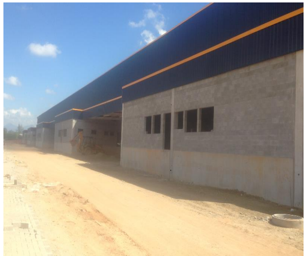
Fachada Principal Execução de Alvenarias
