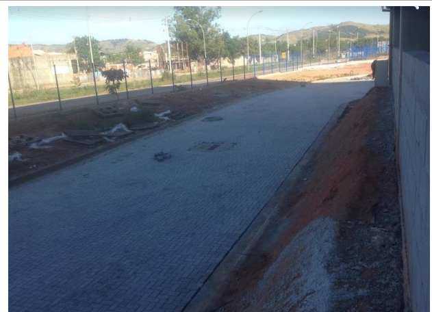
Realização de Intertravados na Rua Quatro
