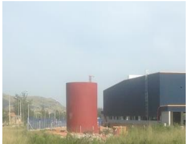
Montagem do Reservatório de água e incêndio.
