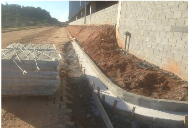
Acerto de Guias e Sarjeta Rua Três com Rua Um
