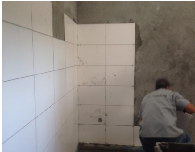
Revestimento de Paredes de Banheiros em Kits.
