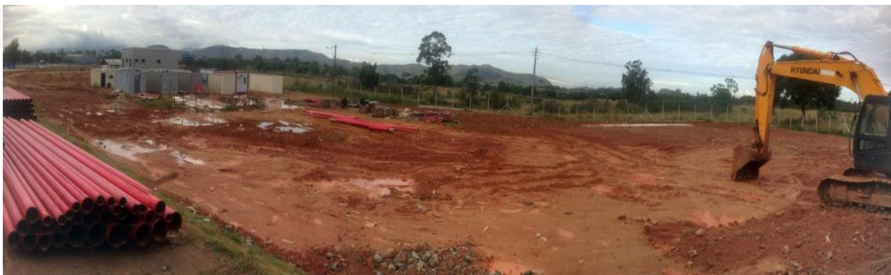
Remoção de Entulho e Arrumação e Limpeza em Área junto ao Canteiro de Obras dos Empreiteiros e a Estrada dos Palmares para acerto do terreno e Plantio de Grama.
