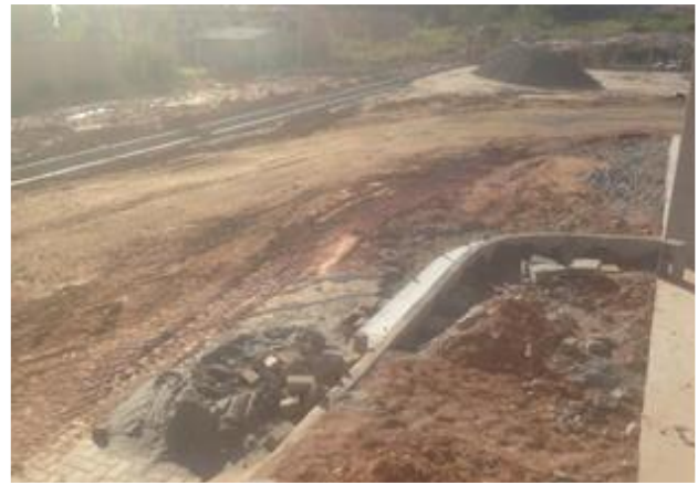
Acerto de Guias e Sarjeta Rua Três com Rua Um
