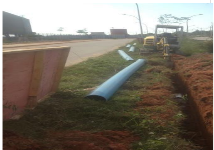
Posicionamento tubos da rede de água potável.
