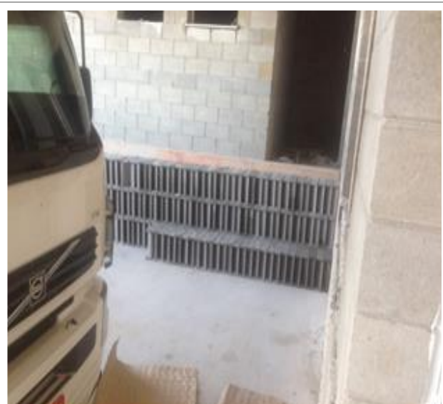
Recebimento das Galerias para Execução dos Serviços de travessia de Ruas. Aguas pluviais.
