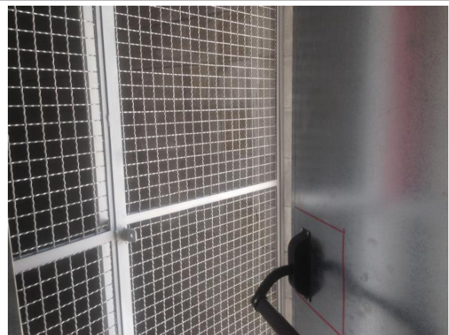
Assentamento de Portas em Chafts das Docas – Total de 10 unds
