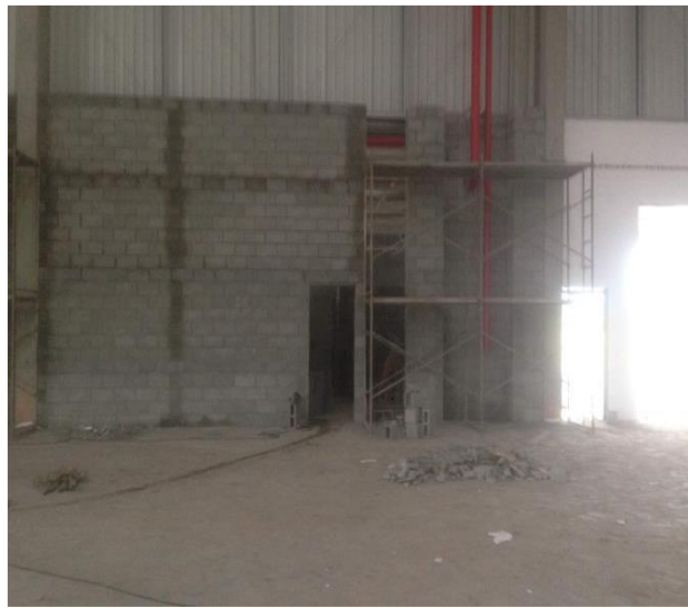
Realização de Alvenarias em Paredes Internas de Kits e Chafits.
