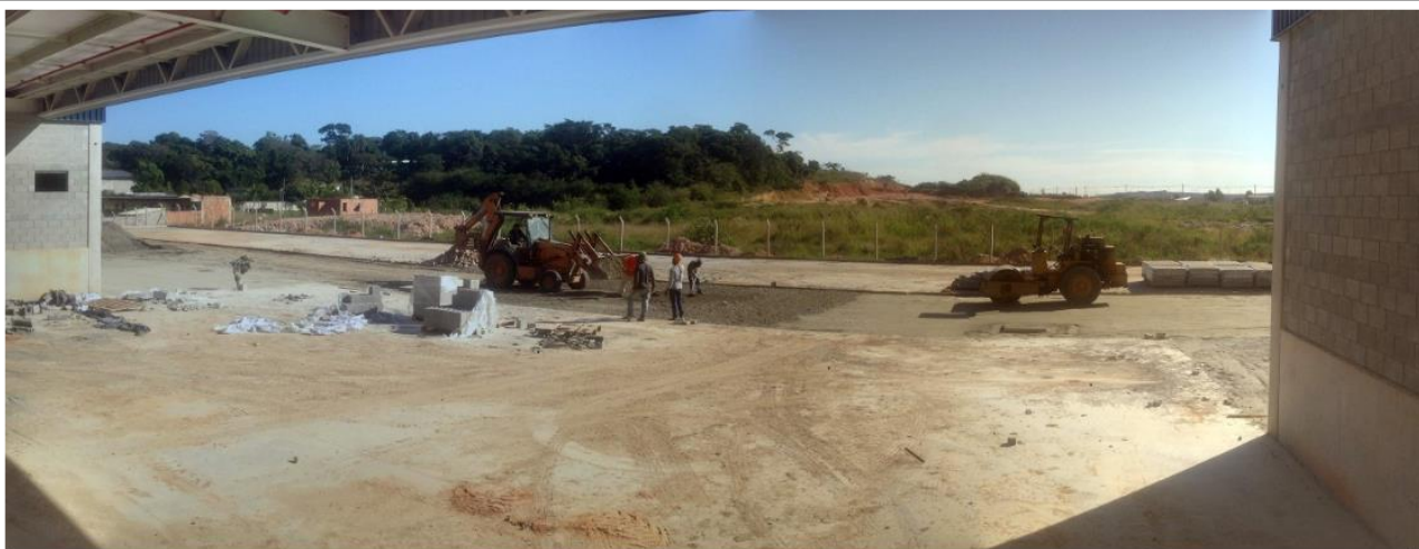
Vista Panorâmica da Obra na Rua Dois na Preparação de Base para assentamento de Intertravados.
