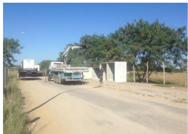
Recebimento das Galerias para Execução dos Serviços de travessia de Ruas. Aguas pluviais.
