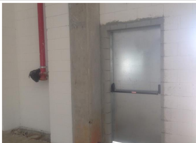
Assentamento de Porta Corta-fogo – Total de 20 unds.
