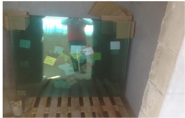
Vidros Blindados da Portaria Principal na Obra.
