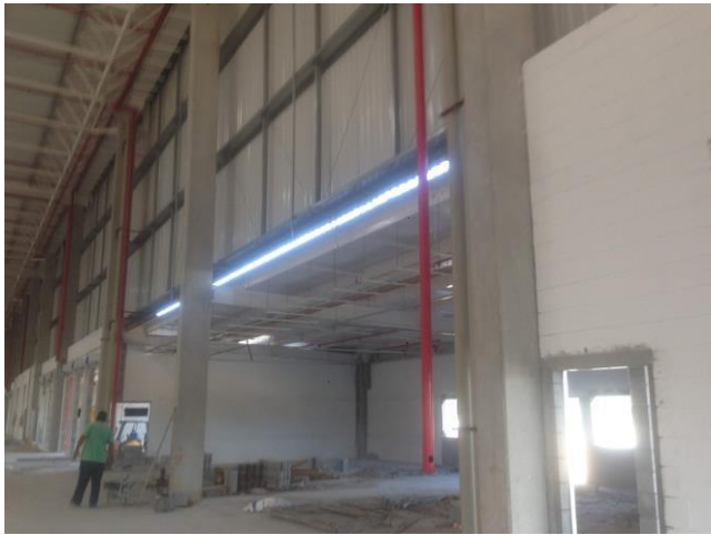
Pintura Interna de Paredes em Andamento.
