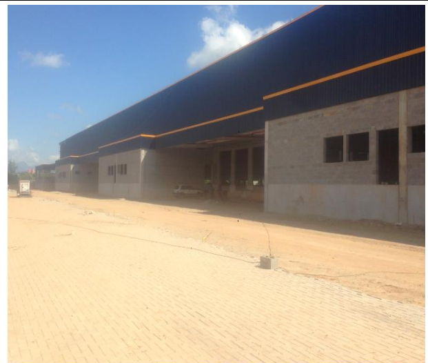
Execução de Intertravados na Rua Um Portaria Principal.
