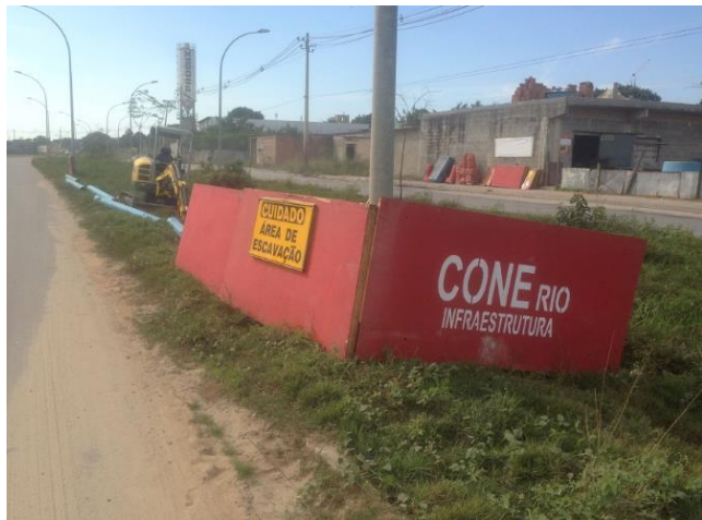
Execução de ampliação de rede de água potável
