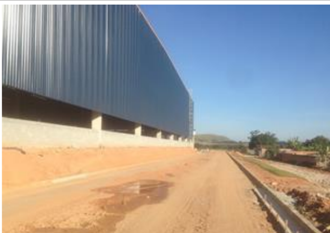
Recuperação de sarjeta rua Três
