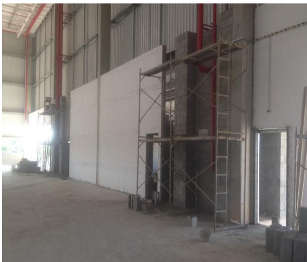
Realização de Alvenarias em Paredes Internas de Kits.
