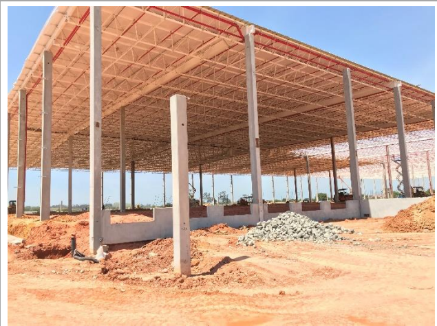
Cobertura metálica – Vista geral do telhamento executado
