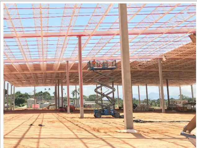
Instalações elétricas – Montagem de eletro calhas de elétrica e iluminação
