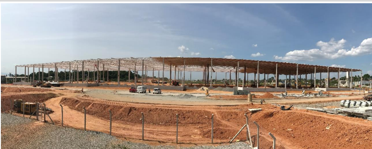
Vista panorâmica da obra
