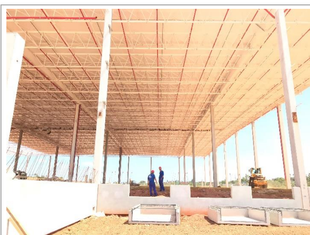
Cobertura metálica – telhamento executado
