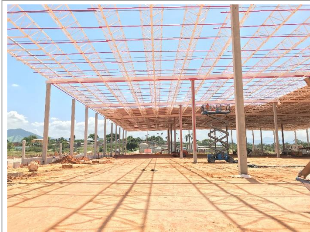
Cobertura metálica – Estrutura metálica
