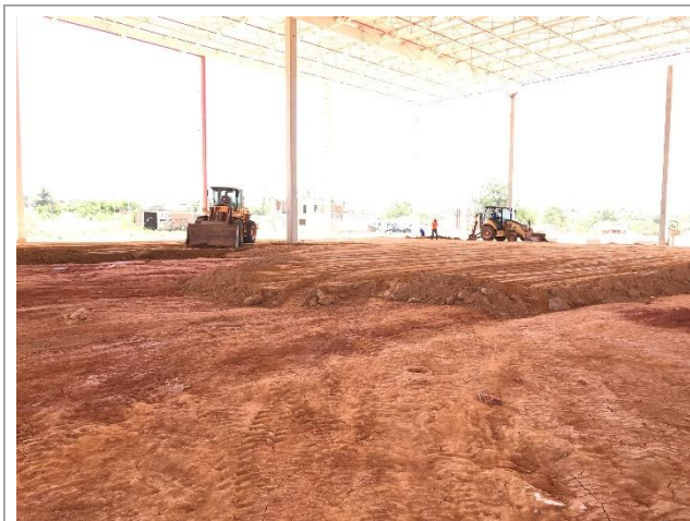
Piso industrial – Preparo de base do piso
