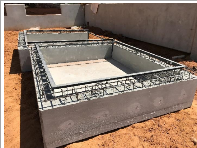
Pré-moldados – Nichos das niveladoras
