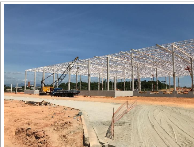
Cobertura metálica – vista geral da estrutura
