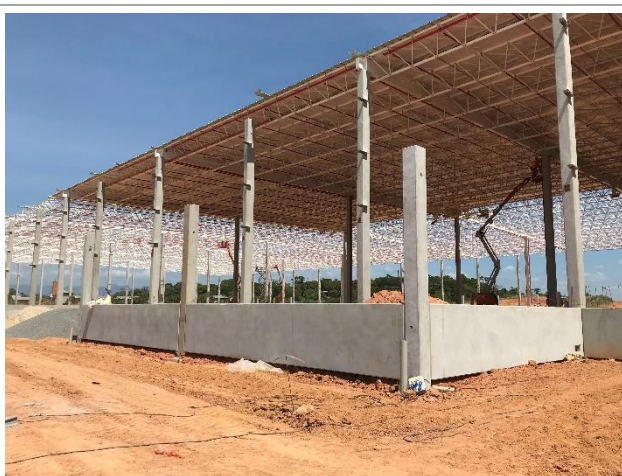
Pré-moldados – Muros de docas
