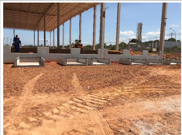
Pré-moldados – Nichos das niveladoras
