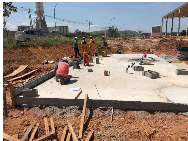
Alvenarias – Execução de alvenarias do cubículo de entrada de energia
