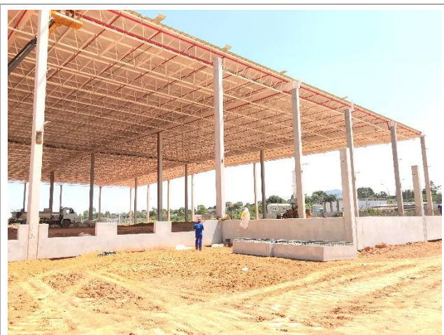
Cobertura metálica – Telhamento executado
