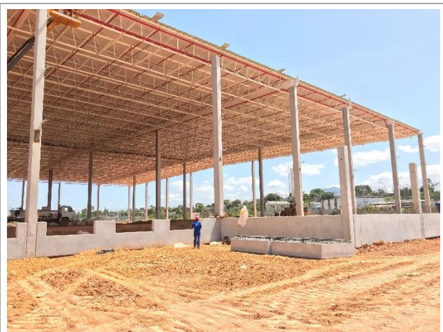
Pré-moldados – Muros de docas
