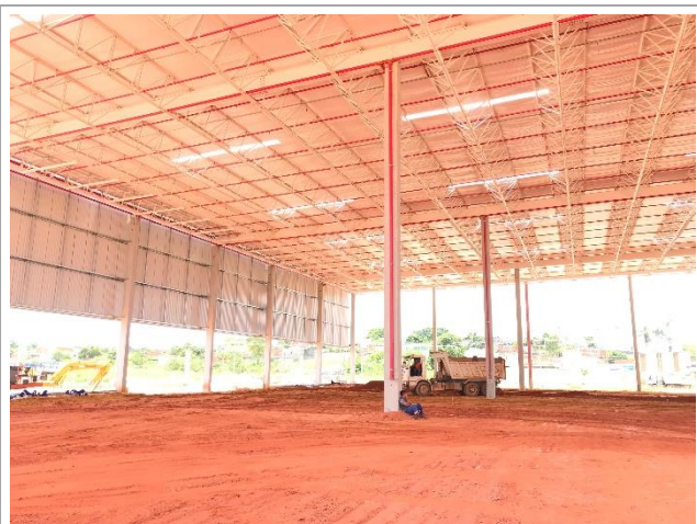
Piso industrial – Preparo de base do piso
