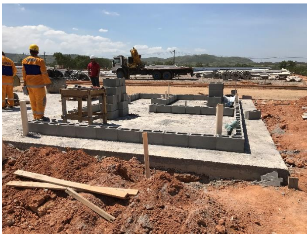
Alvenarias – Execução de alvenarias da portaria
