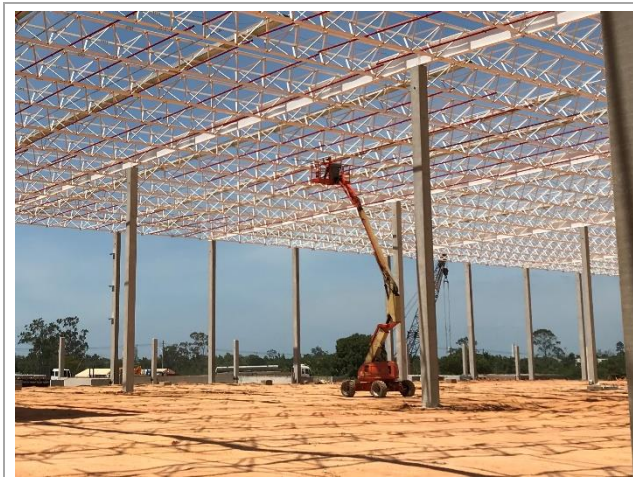
Combate à Incêndio – Montagem de tubulação da rede de sprinklers
