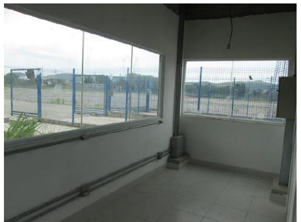
Edificação 3 – Portaria (Área interna)
