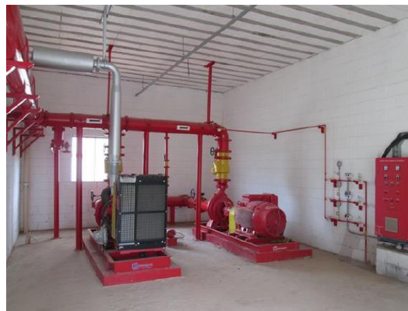
Casa de Bombas
