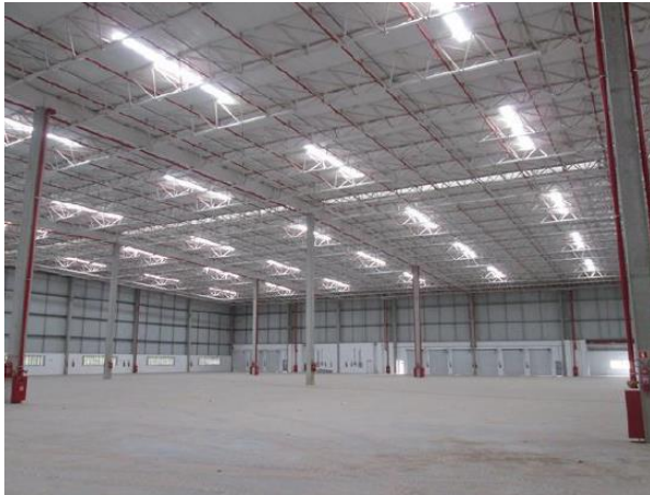
Edificação 1 – Galpão (Área interna)
