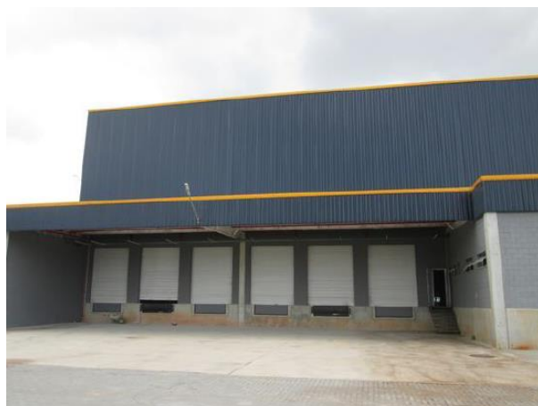
Edificação 1 – Galpão (Docas)
