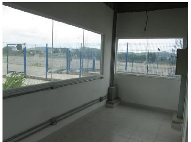
Edificação 3 – Portaria (Área interna)
