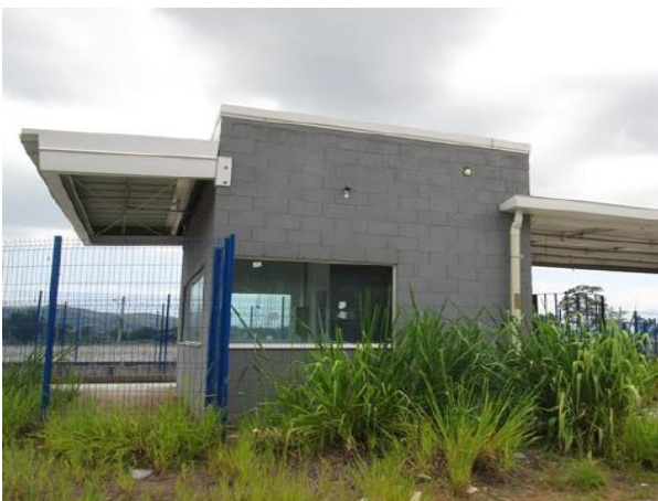
Edificação 3 – Portaria (Fachada)
