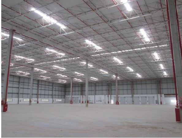
Edificação 1 – Galpão (Área interna)
