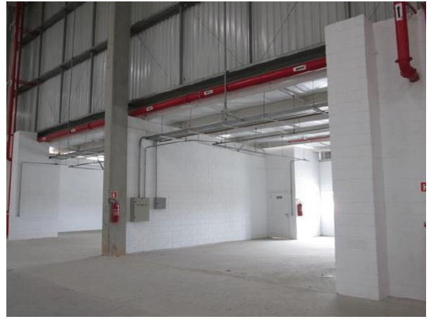
Edificação 1 – Galpão (Área interna)
