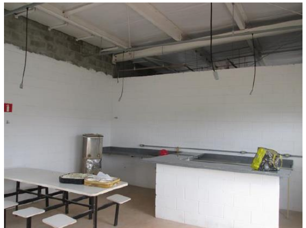
Edificação 2 – Refeitório (Área interna)
