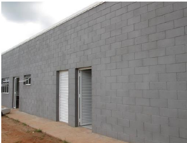
Edificação 2 – Refeitório (Fachada)
