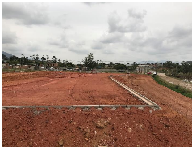
Execução de guias e sarjetas no estacionamento externo
