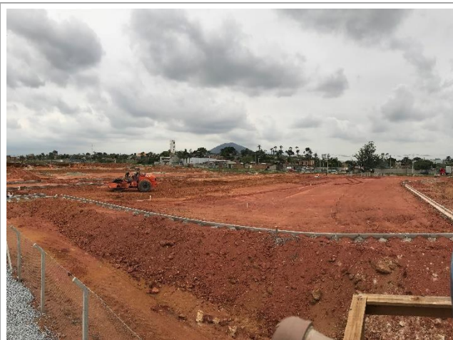
Vista geral do preparo das ruas e pátio de estacionamento
