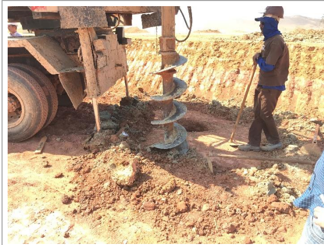
Execução de estacas escavadas das fundações do galpão
