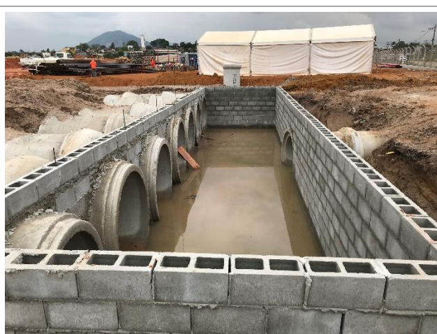
Caixa de retardo – Cabeceira de saída executada
