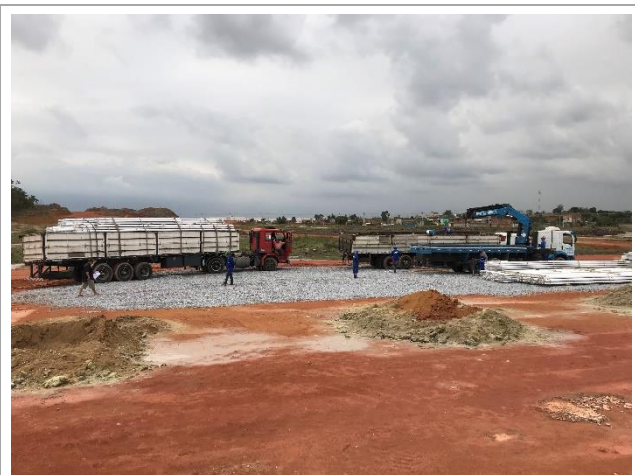
Materiais para montagem da estrutura metálica
