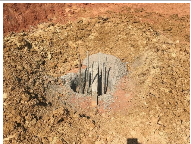
Estaca escavada executada
