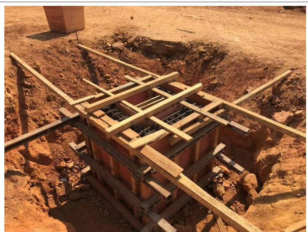
Forma e armação de bloco montados para receber concretagem
