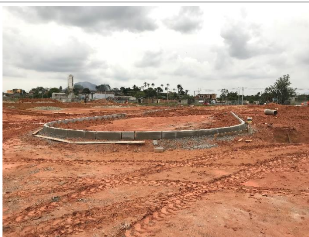
Execução guias e sarjetas na região da portaria
