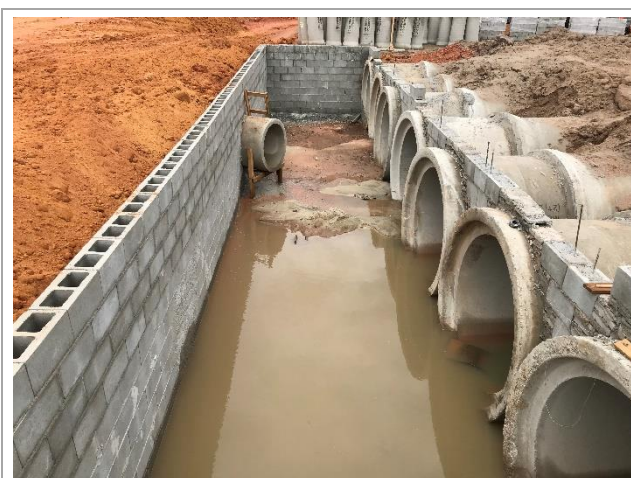
Caixa de retardo – Cabeceira de entrada executada
