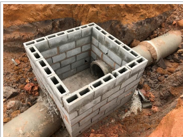
Drenagem – Caixa de passagem
