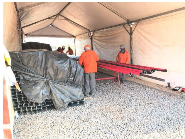
Pintura de tubulações de combate a incêndio
