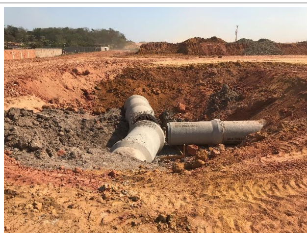
Drenagem – Tubulação enterrada
