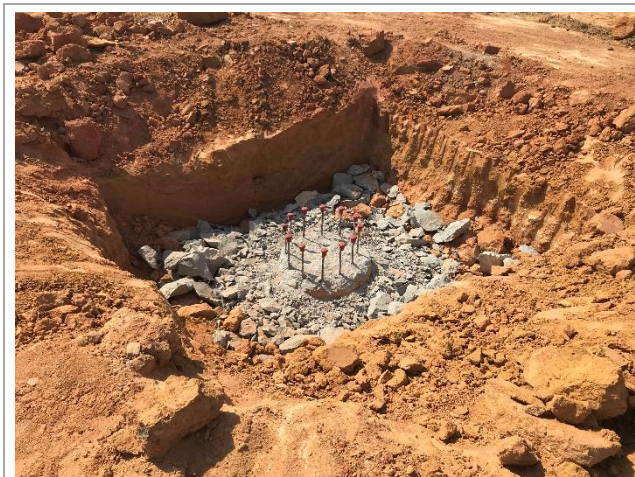
Arrasamento de estacas para execução dos blocos de fundação
