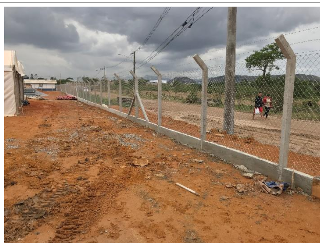
Trecho do alambrado perimetral executado
