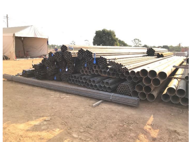
Tubos para rede de combate a incêndio recebidos em obra
