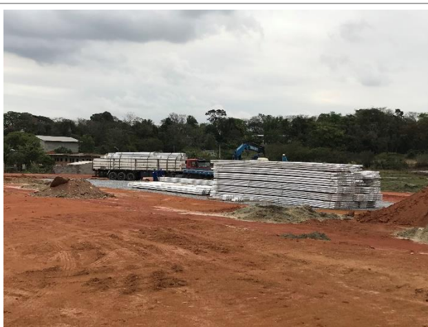
Materiais para montagem da estrutura metálica
