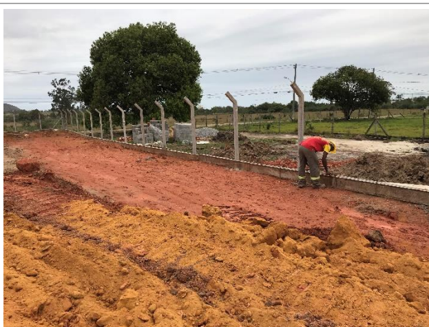
Alambrado perimetral em execução
