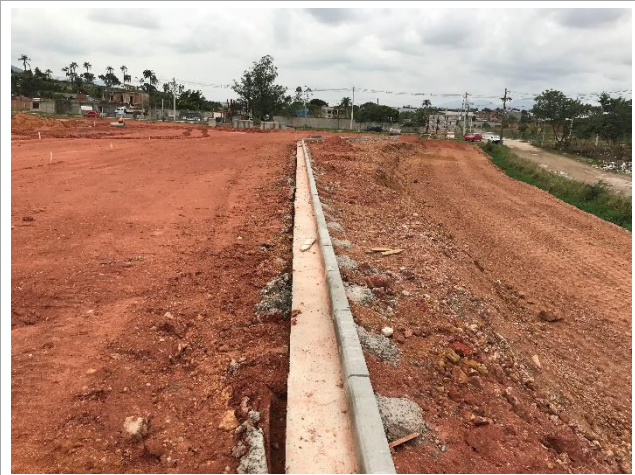
Execução de guias e sarjetas no estacionamento externo
