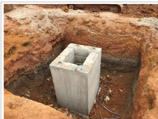
Bloco de fundação concluído
