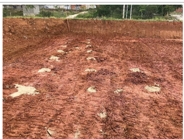
Locação da fundação profunda do reservatório metálico
