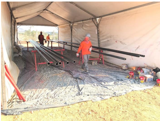
Preparo de tubulações de combate a incêndio
