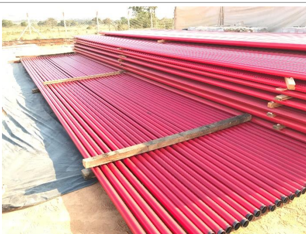
Tubos de combate a incêndio preparados para montagem
