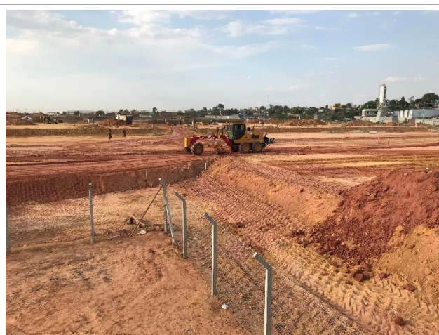
Serviço de terraplenagem na região da portaria
