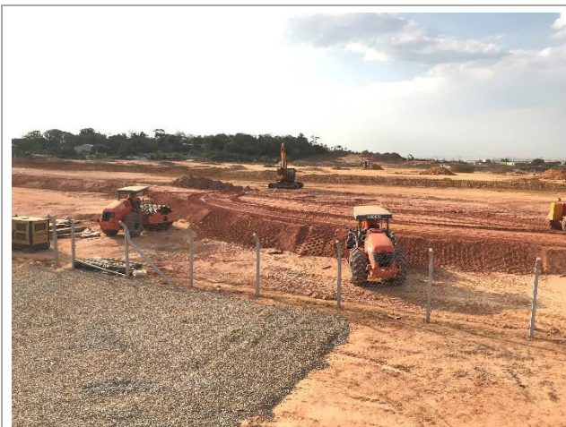
Platô do galpão finalizado ao fundo e máquinas ajustando talude
