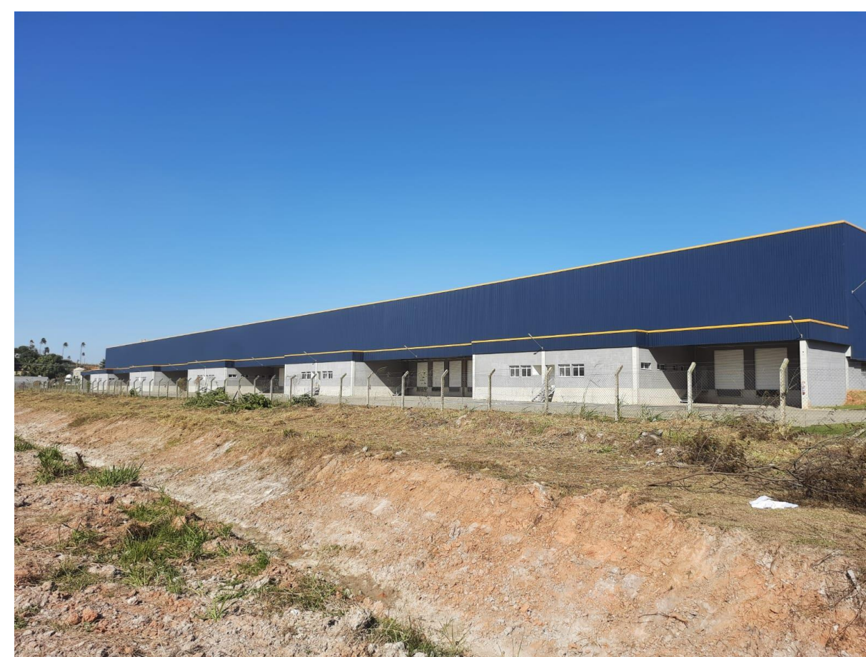
Limpeza e recomposição da vala 2 de drenagem interna
