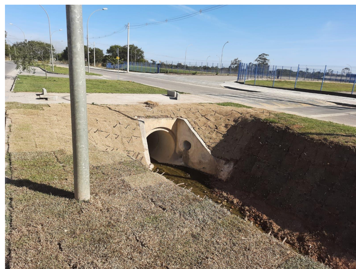
Aplicação de Grama no canteiro e vala de drenagem externa
