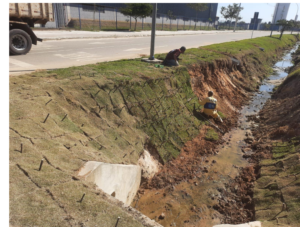
Limpeza e aplicação de grama na vala de drenagem externa
