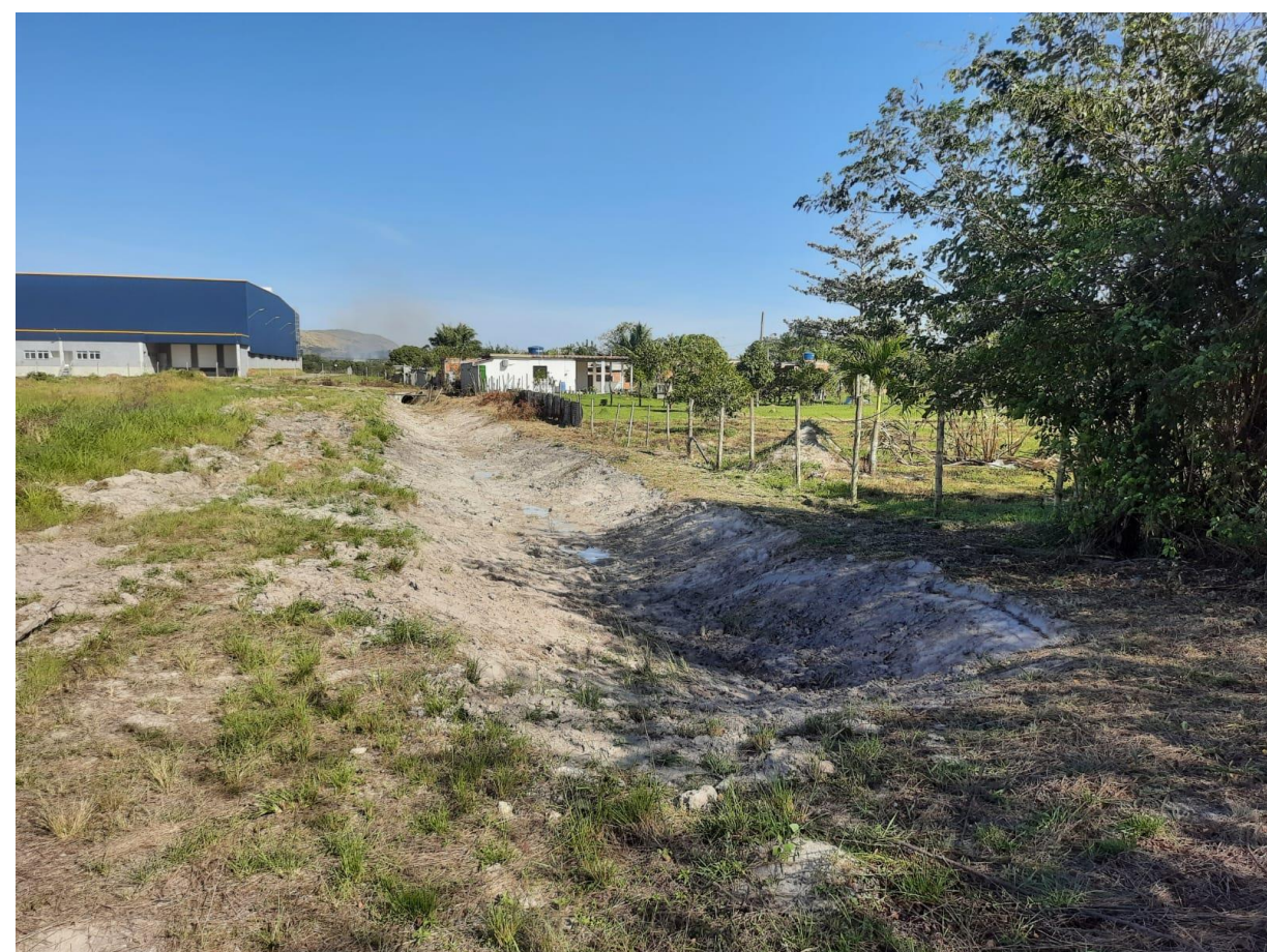
Limpeza e recomposição da vala 1 de drenagem interna
