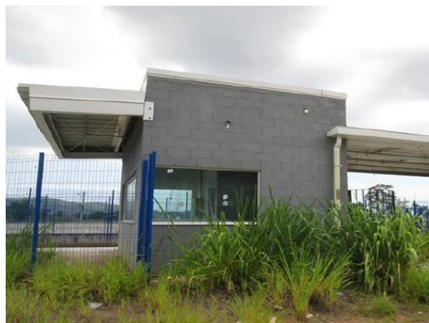
Edificação 3 – Portaria (Fachada)
