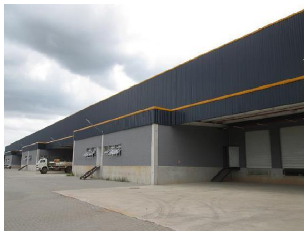
Edificação 1 – Galpão (Fachada)
