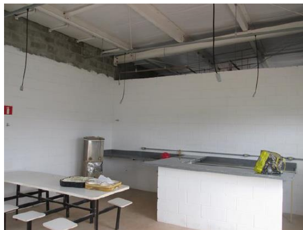
Edificação 2 – Refeitório (Área interna)
