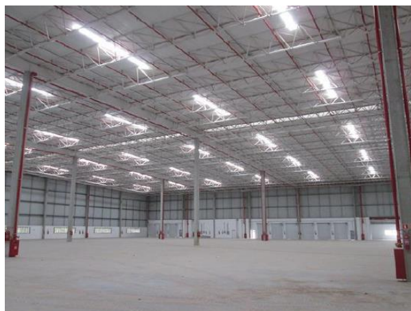
Edificação 1 – Galpão (Área interna)
