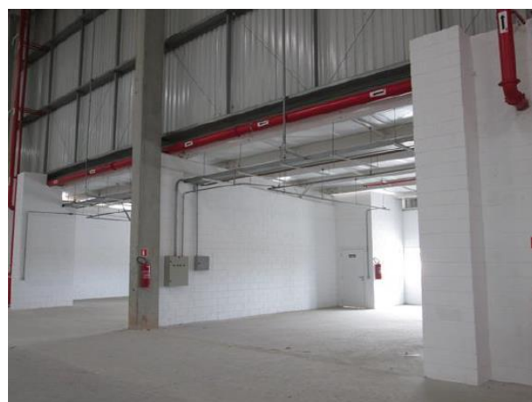
Edificação 1 – Galpão (Área interna)
