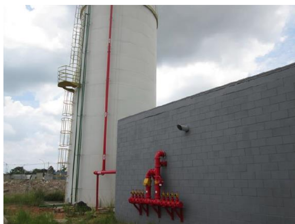
Reservatório e Casa de Bombas
