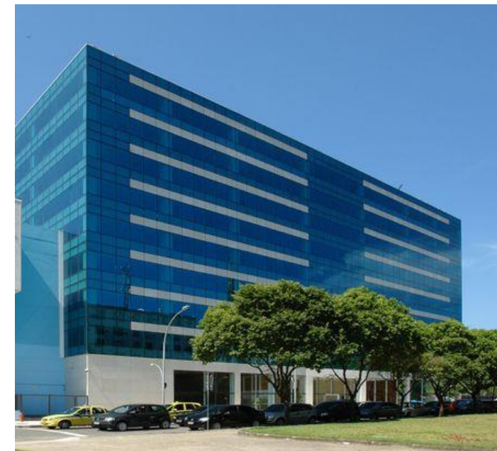
Rio Cidade Nova - Torre Norte
