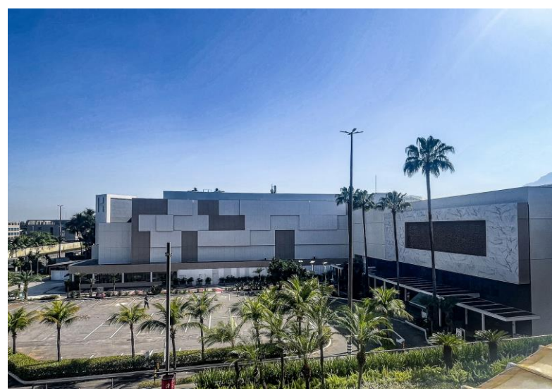
Estacionamento VIP, local da expansão futura do BarraShopping
