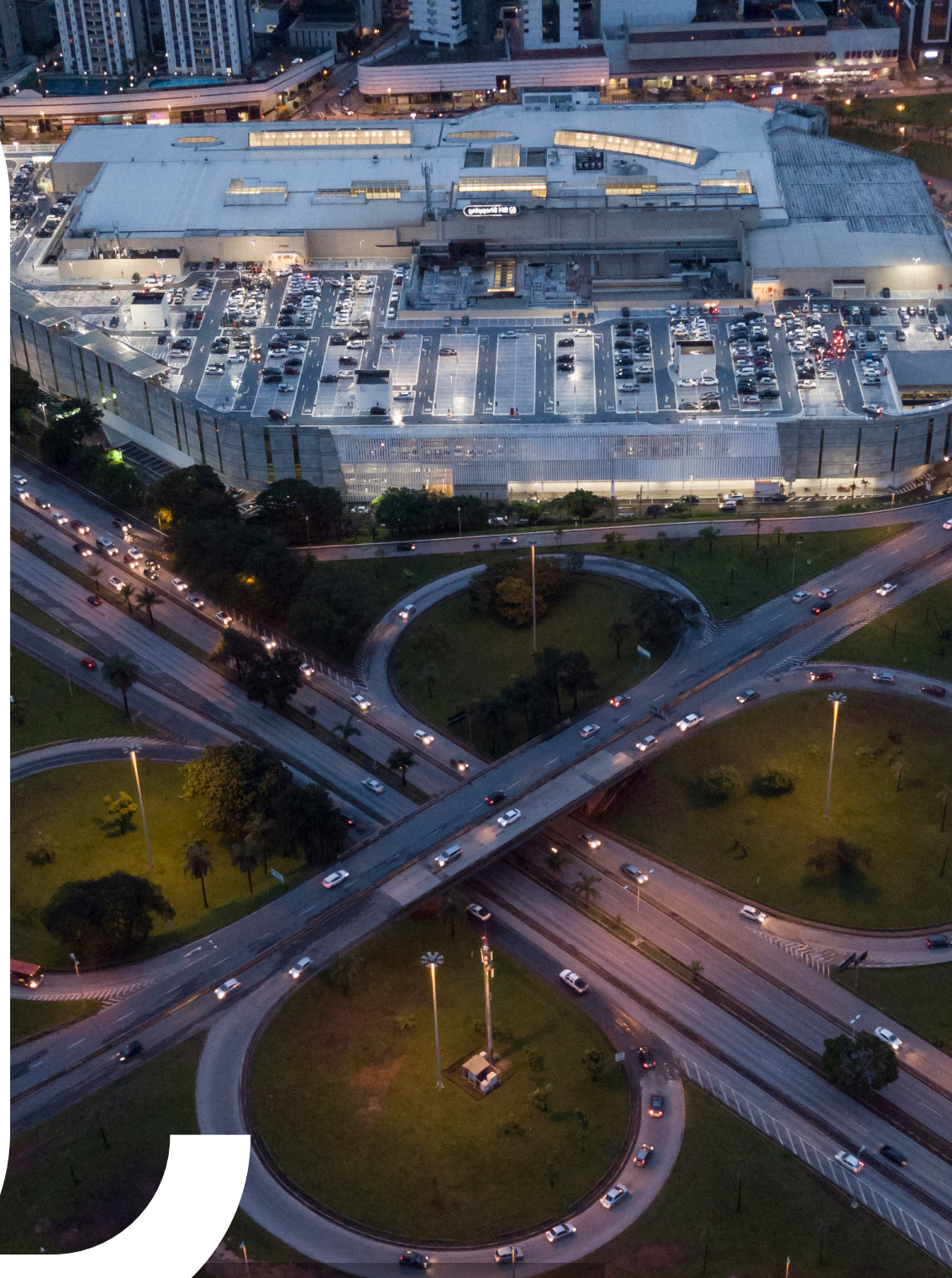
Rodovia no entorno do BH Shopping, MG.
