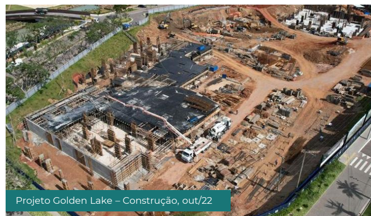
Projeto Golden Lake – Construção, out/22
