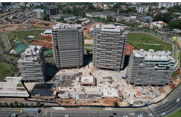
Construção da fase I do Golden Lake (Lake Victoria) – out/24
