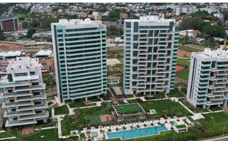
Construção da fase 1 do Golden Lake (Lake Victoria) – dez/25
