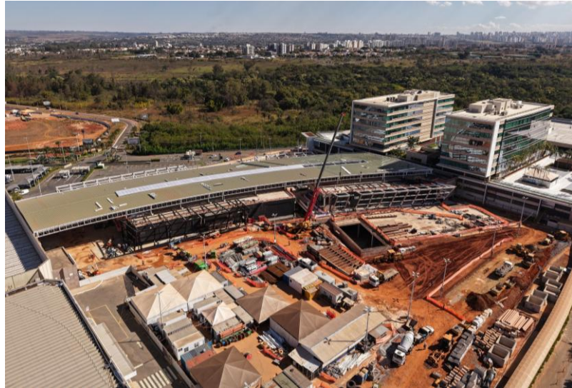
ParkShopping – Expansão em construção
