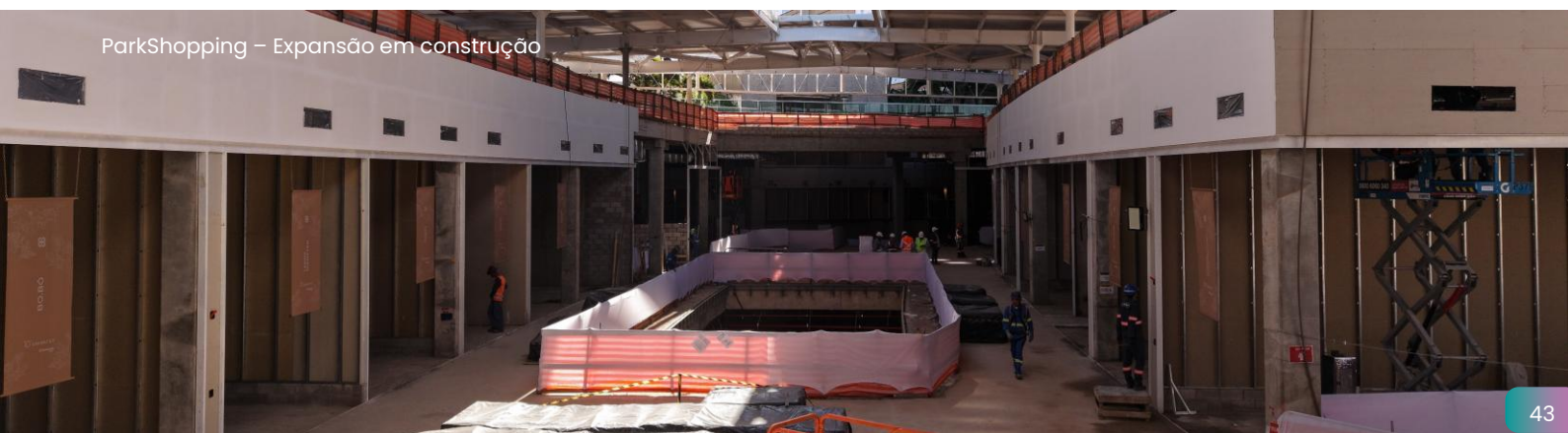
BarraShopping – Expansão em construção
