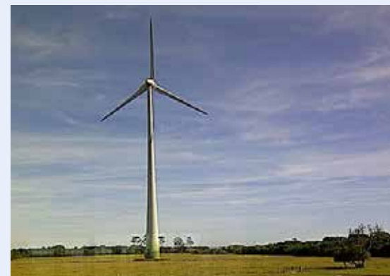
Osório wind farm (Rio Grande do Sul state) Photo: BNDES collection/Alexandre da Silva Pereira
