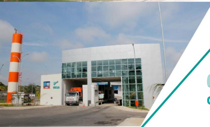
Estação de Transferência de Resíduos
