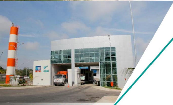
Estação de Transferência de Resíduos
