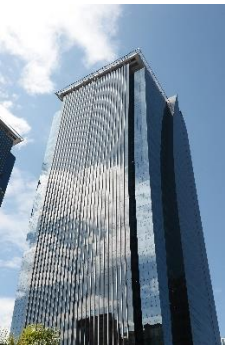
EZ Towers – Torre A São Paulo - SP
