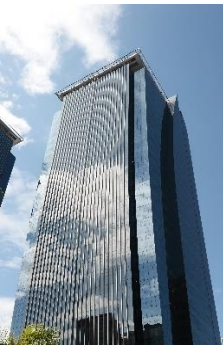
EZ Towers – Torre A São Paulo - SP
