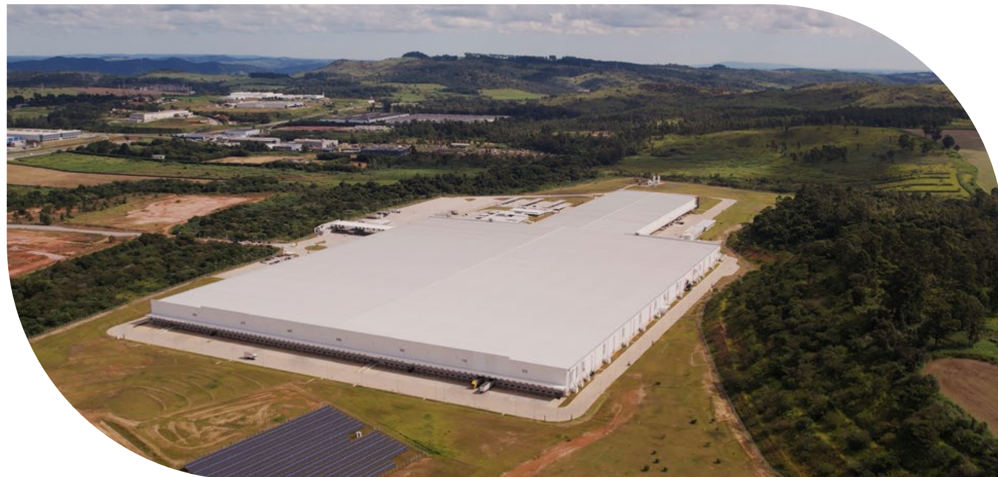
Centro de Distribuição omnichannel em Cabreúva (SP).
