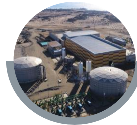
Planta Desaladora: Cleanairtech
