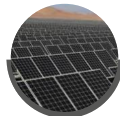
Estructuras para paneles solares
