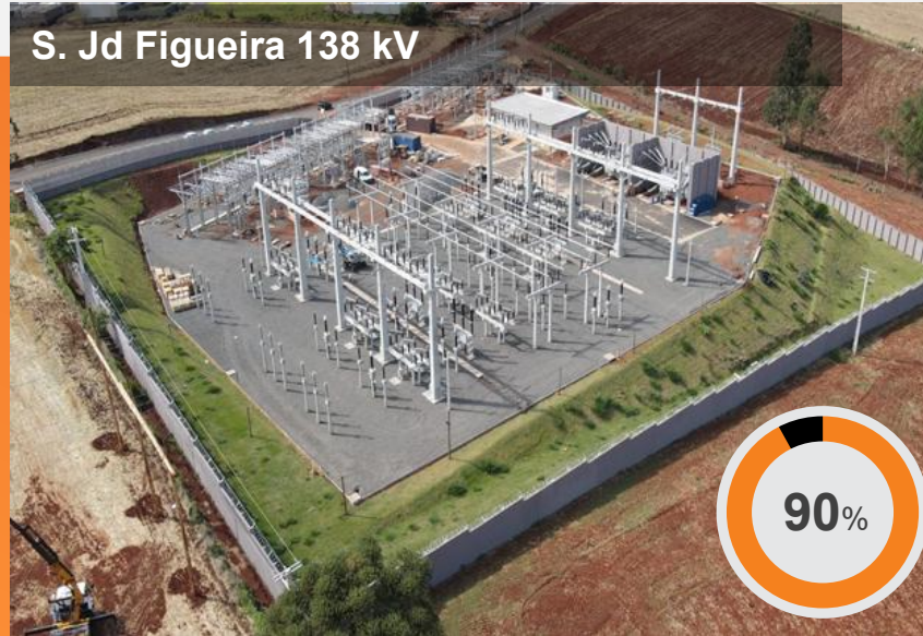
S. Capitão Leônidas Marques 138 kV
