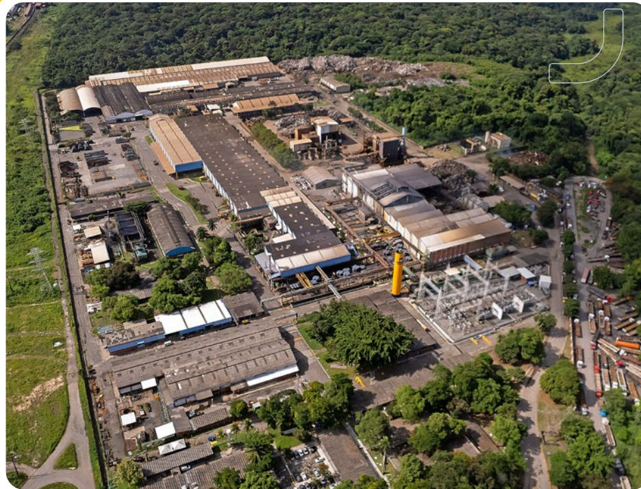
Açonorte mill, Recife (PE)
