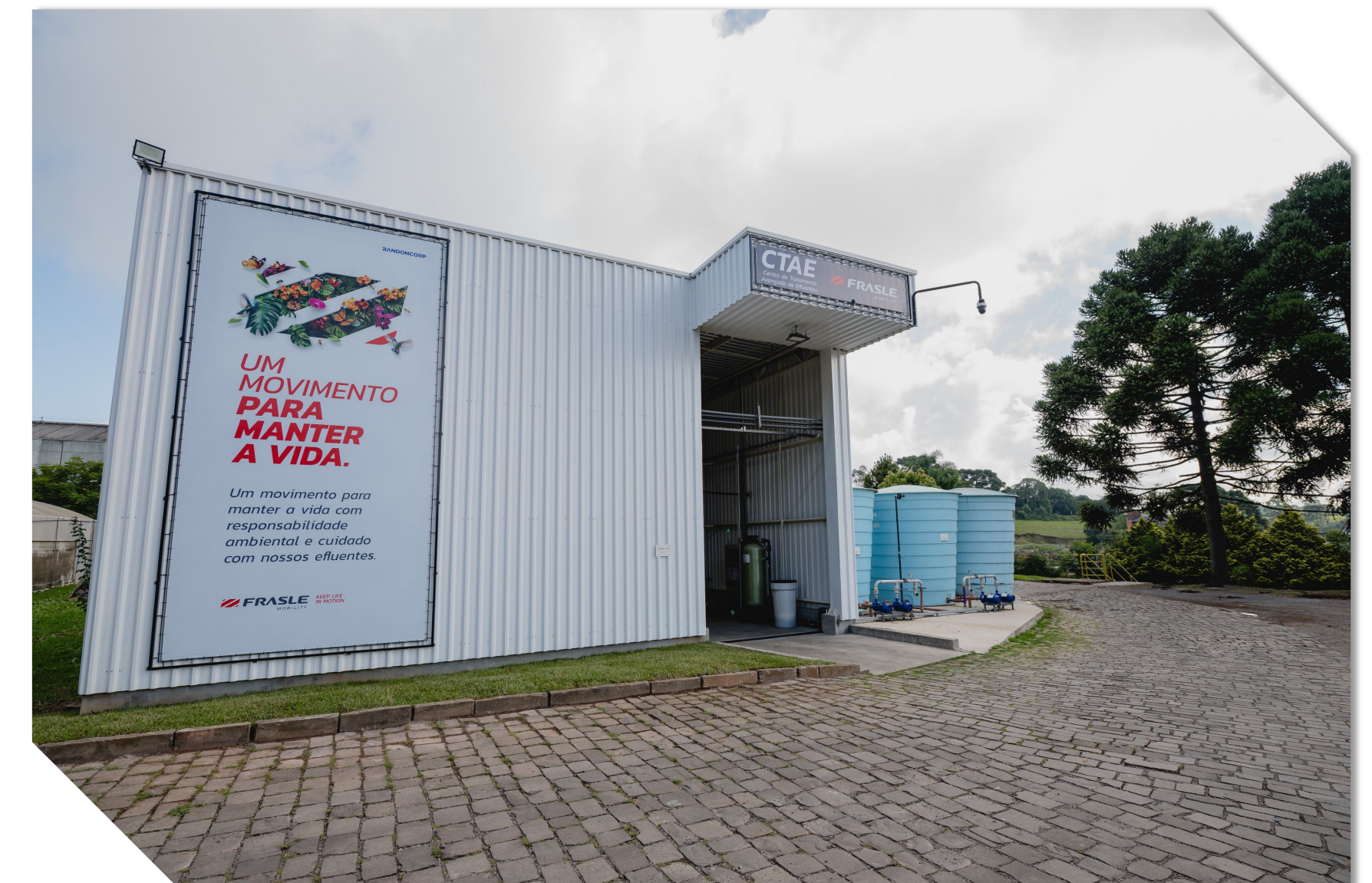
INAUGURAÇÃO DE 3 ESTAÇÕES DE TRATAMENTO DE ESGOTO (ETES) PRÓPRIAS
