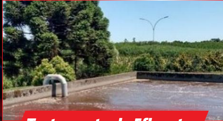
Tratamento de Efluentes
