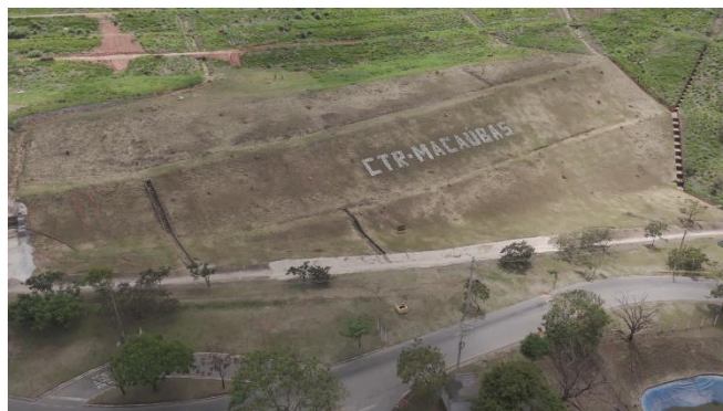
Imagem 4: Central de Tratamento de Resíduos – Macaúbas (MG)
