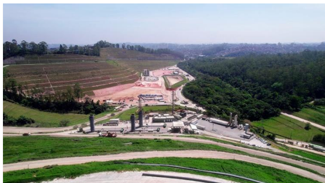
Imagem 2: Central de Tratamento Leste – Ecourbis (SP)
