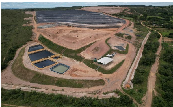
Imagem 3: Central de Tratamento de Resíduos – Baru (GO)
