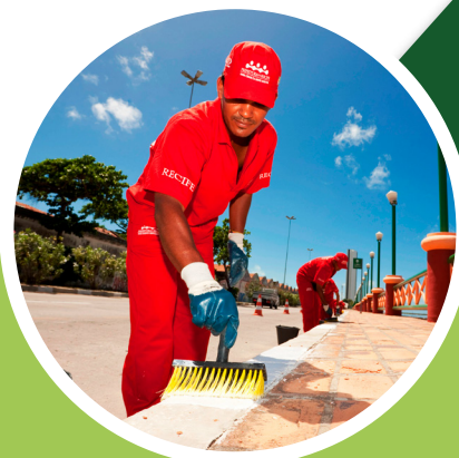
PINTURA DE MEIOS-FIOS
