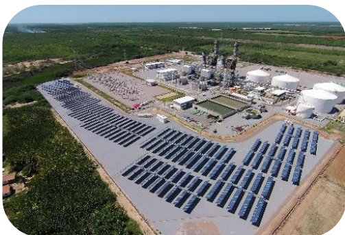
Usina Fotovoltaica de Alto Rodrigues, no Rio Grande do Norte
