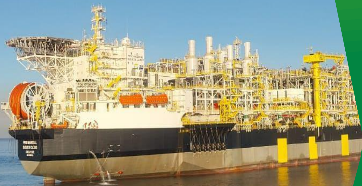
FPSO Mal Duque de Caxias
