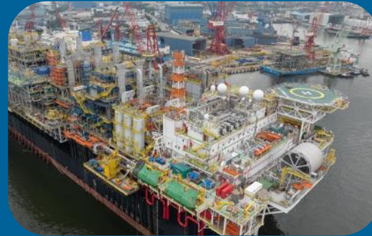
P-78 Concluído o içamento dos módulos
