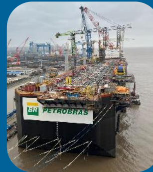
P-82 Casco e módulos em construção
