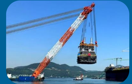
P-79 Concluídos os 5 módulos executados no Brasil. Içamento dos módulos em andamento
