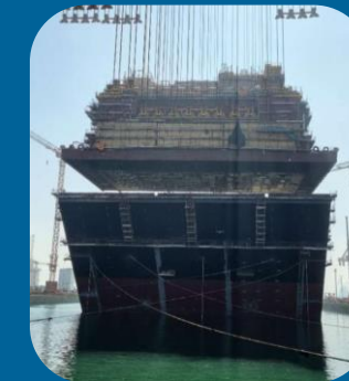
P-83 Casco e módulos em construção
