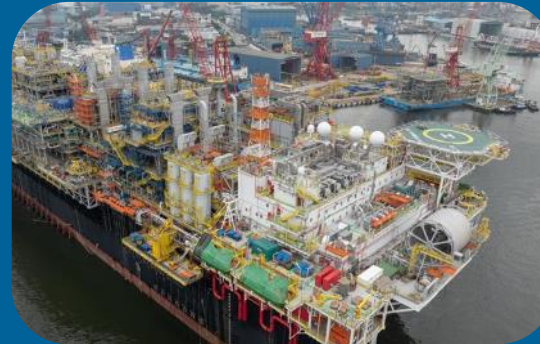
P-78 Concluído o içamento dos módulos
