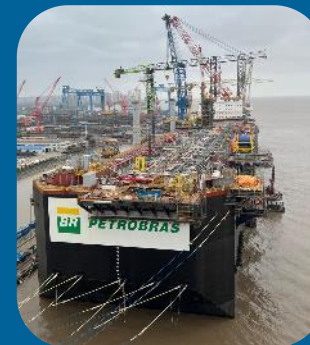
P-82 Casco e módulos em construção
