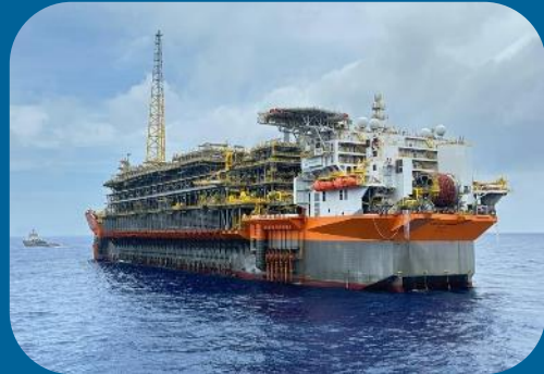
FPSO Almirante Tamandaré na locação
