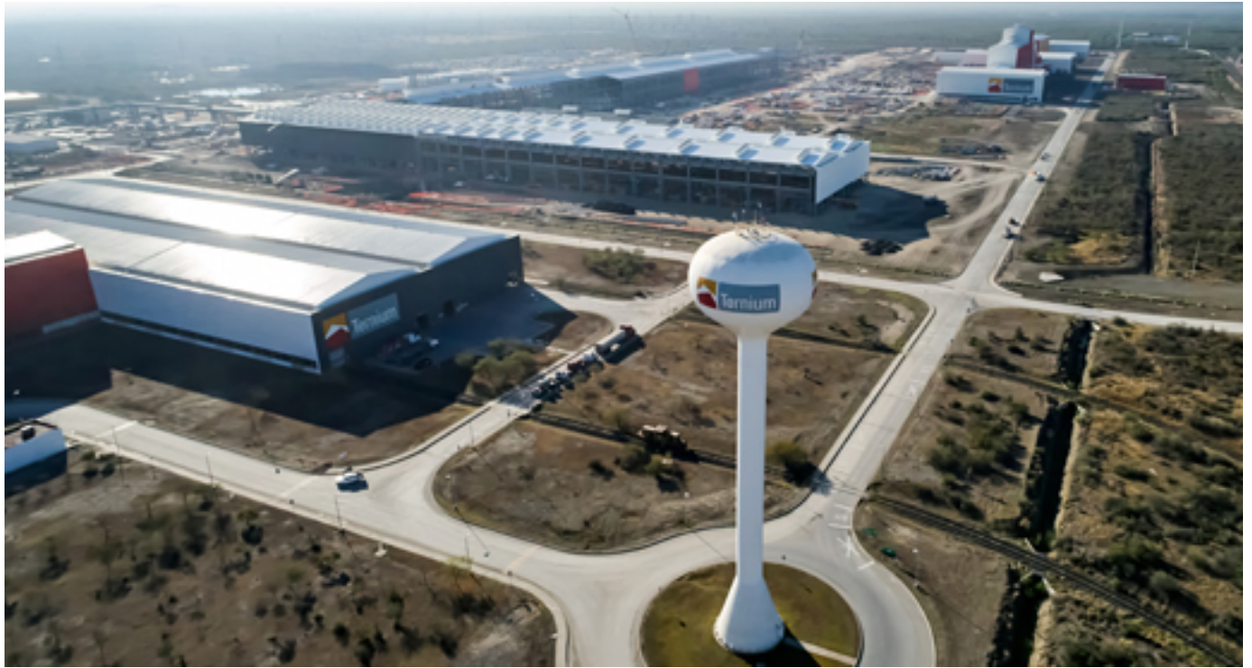
Unidad Pesquería de Ternium. Inaugurada en 2013, el nuevo centro industrial ha incorporado instalaciones de laminación en frío, galvanizado y pintado, e incorporará un nuevo laminador en caliente en 2021.
