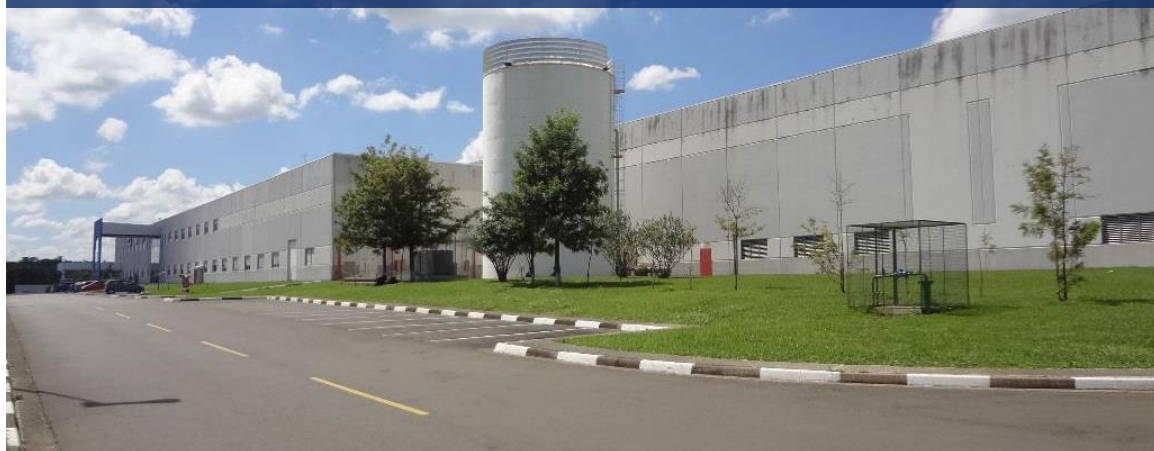
Acesso para o pátio
