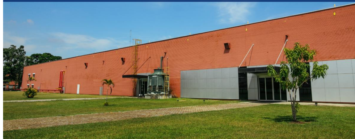
Galpão – área externa
