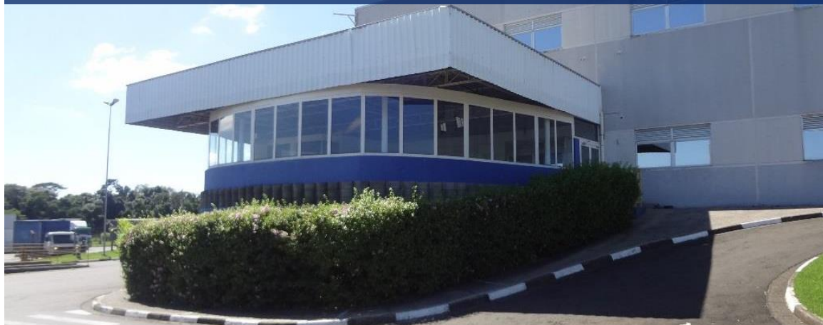
Entrada do galpão
