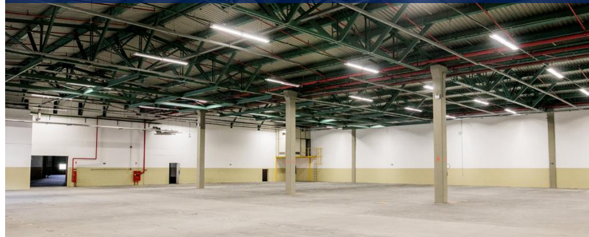
Galpão – área interna
