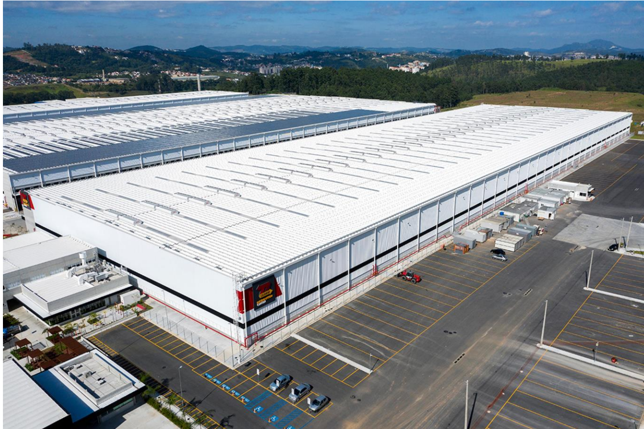
Vista Geral do Galpão
