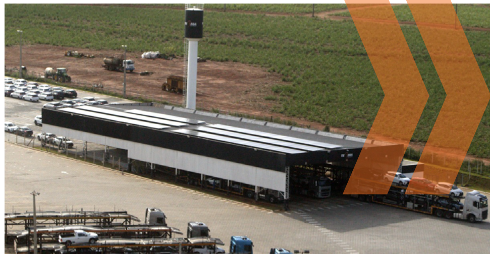
Usina de energia fotovoltaica na unidade de Sorocaba
