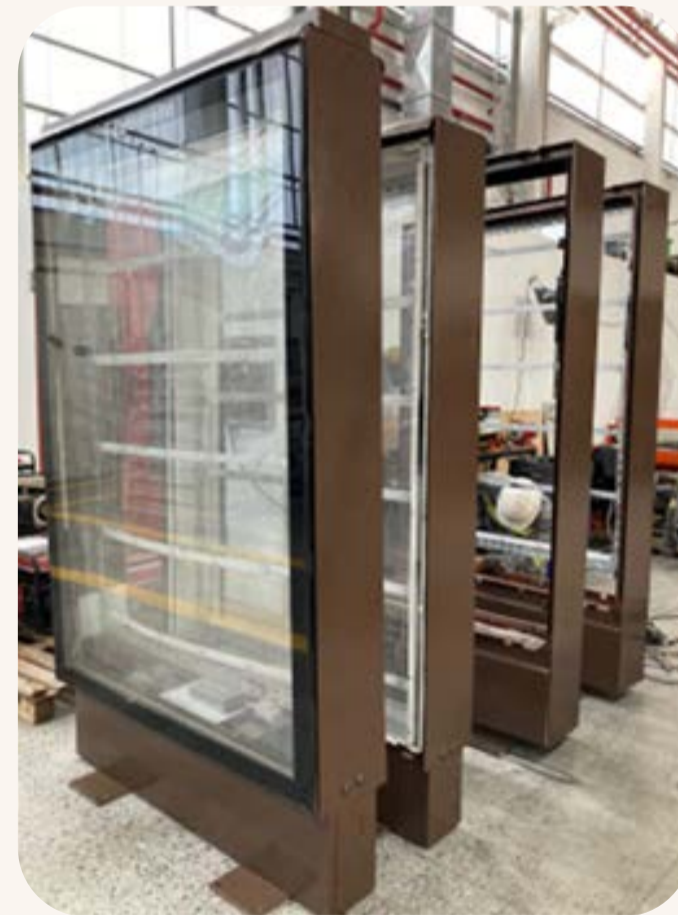
Lixamento, substituição das partes metálicas e pintura.
