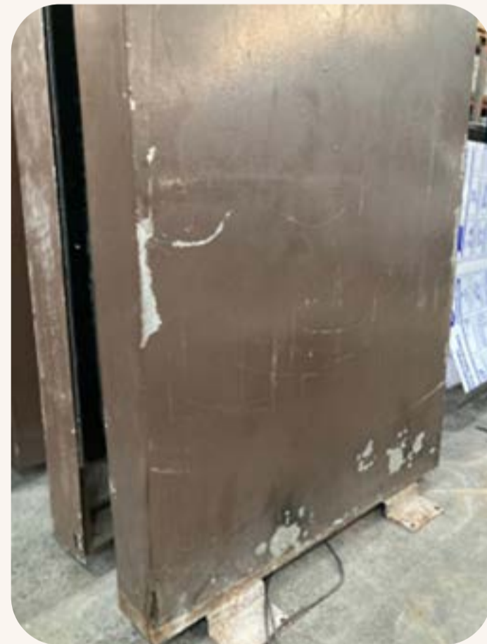
Remoção dos painéis da rua com sinais de oxidação.
