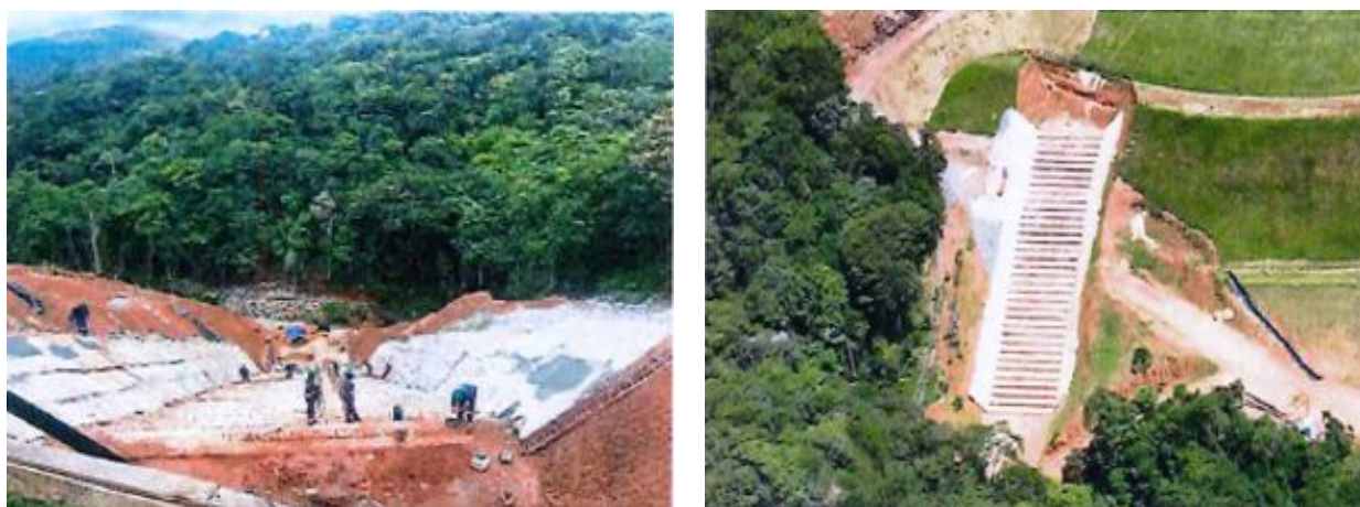
Figura 5 - Registro da estrutura DE-02 após sua implantação.
