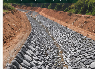
Exemplo de canal de drenagem (em implantação/adequação)
