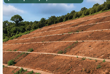
Exemplo de proteção superficial (em implantação)
