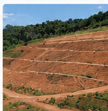
Taludes da SD-02 (em adequação) (Fonte: EIA)
