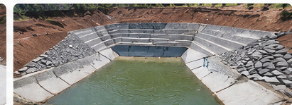
Bacia de dissipação da DE-02 (em implantação) (Fonte: EIA)
