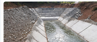
Escada hidráulica da DE-02 (Fonte: EIA)
