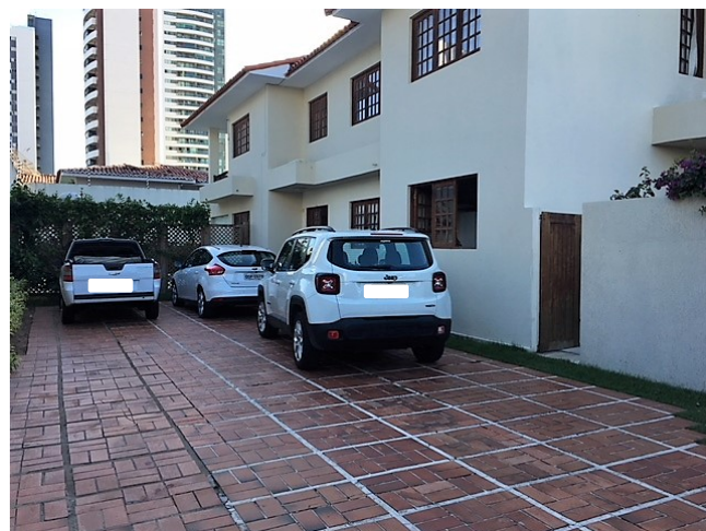
Figura 8. Estacionamento privativo da START
