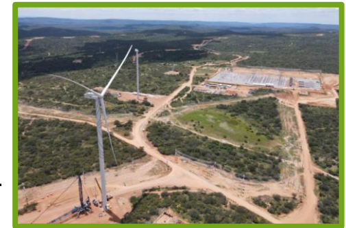
Montagem aerogerador OITIS 05 com SE ao fundo
