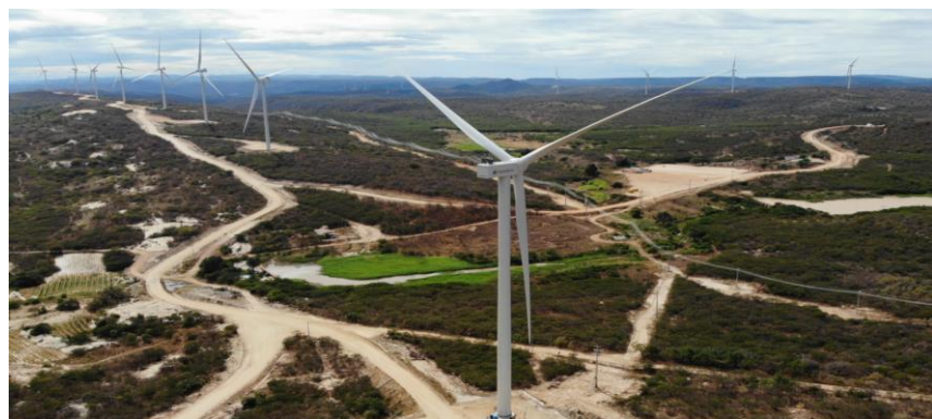
FOTO: Complexo Chafariz - Operação em testes
