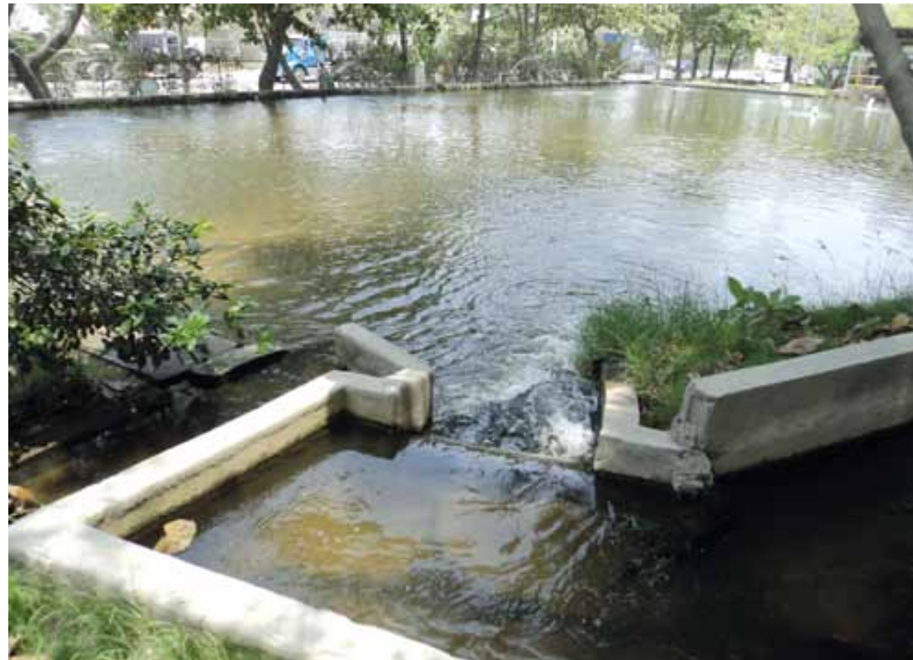
Recirculación de agua Planta Cartagena, Colombia
