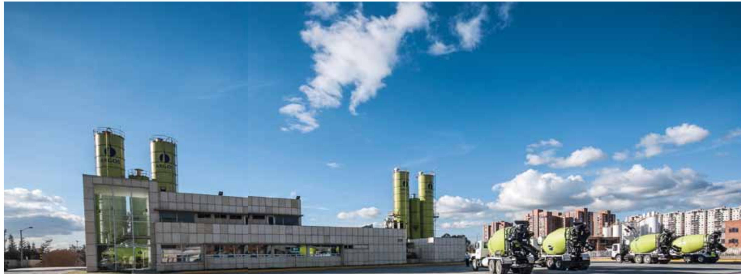
Planta Puente Aranda, Colombia
