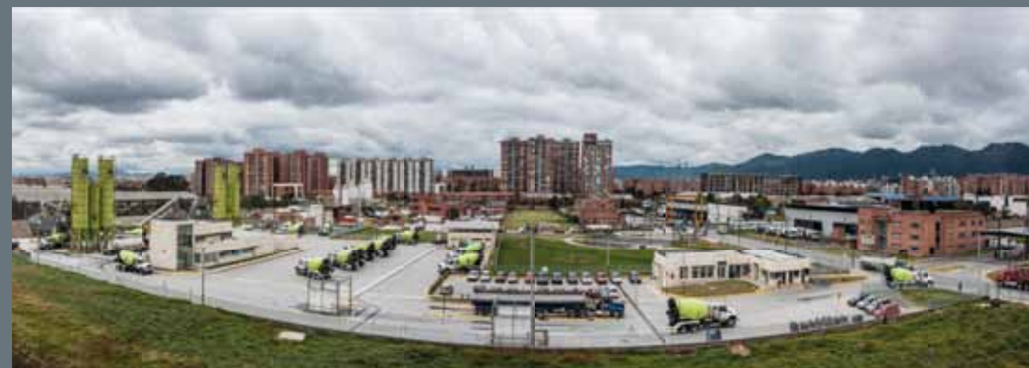
Planta Puente Aranda, Colombia
