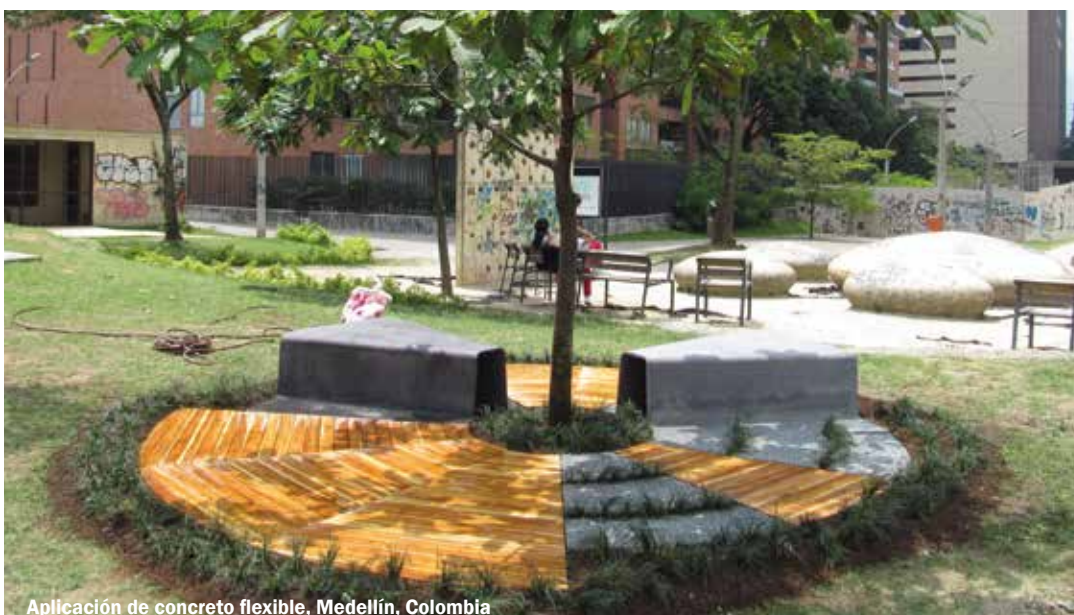
Aplicación de concreto flexible, Medellín, Colombia
