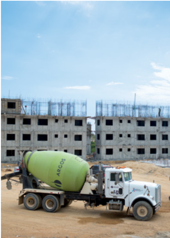
↑ Camión mezclador en proyecto de construcción de vivienda en República Dominicana
