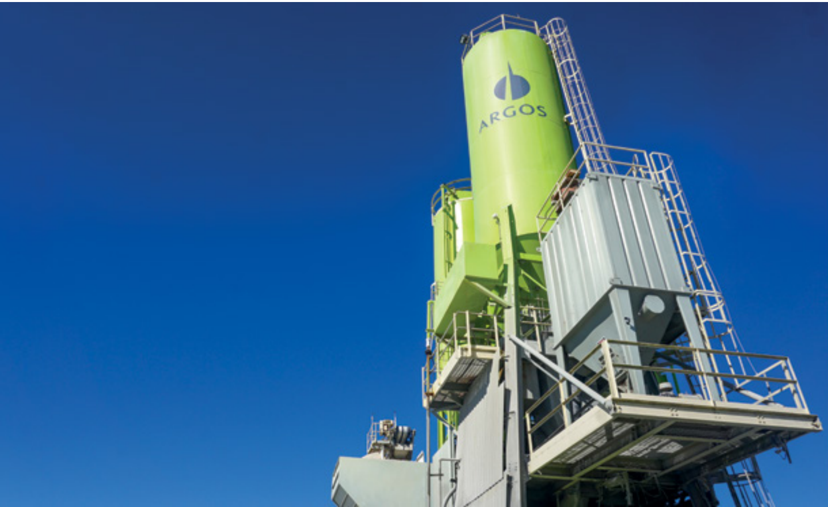
↑ Planta de concreto en la calle 78 de Tampa, Florida, Estados Unidos
