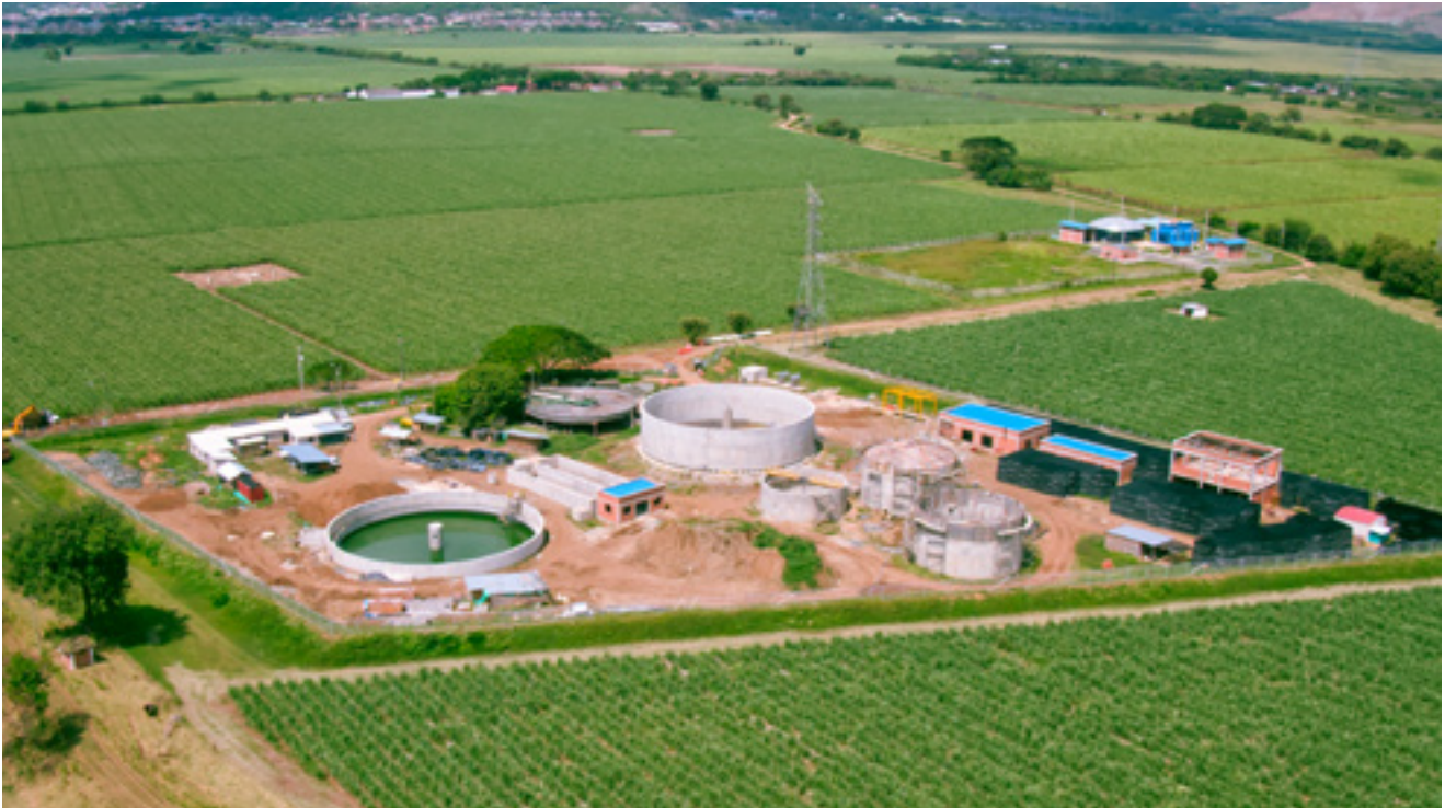
↑ Construcción de planta de tratamiento de aguas residuales en el Valle del Cauca, Colombia
