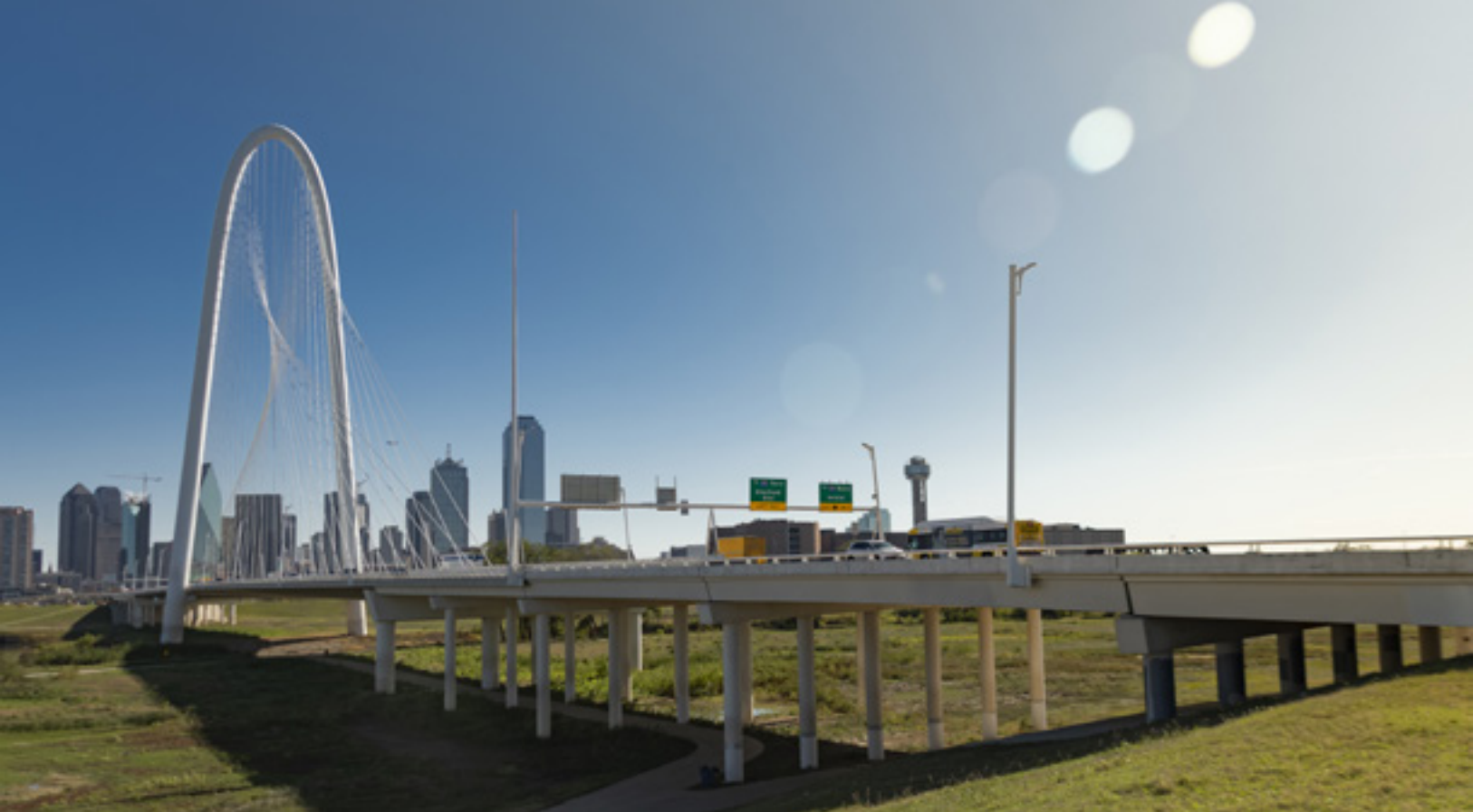
↑ Puente Margaret Hunt Hill, una obra con el sello Argos en Dallas, Estados Unidos
