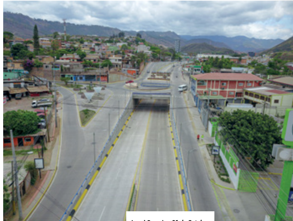
Level Crossing 21 de Octubre. Tegucigalpa, Honduras.
